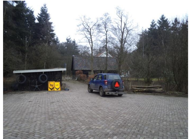
Houthok, opslagschuur/veldschuur, daarachter landhuis
