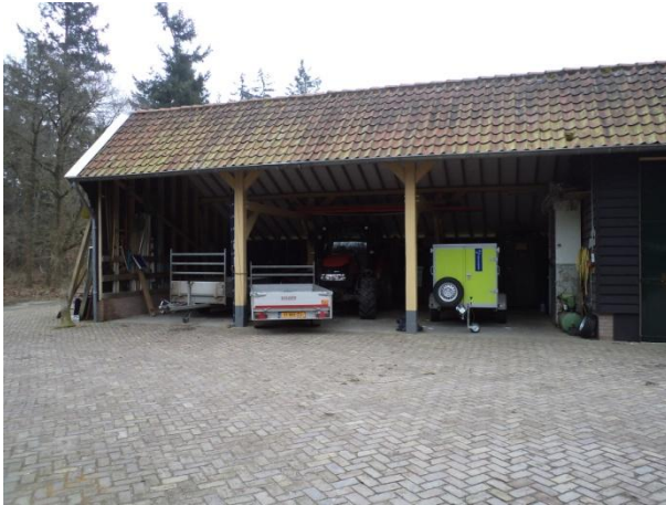
Oostelijk deel werkschuur: stalling trekker, materieel, werktuigen etc.
