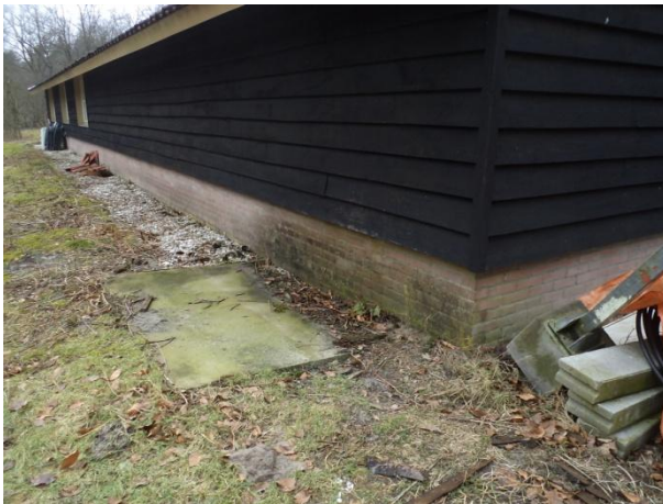
Voormalige locatie bovengrondse dieseltank op zuidoosthoek werkschuur
