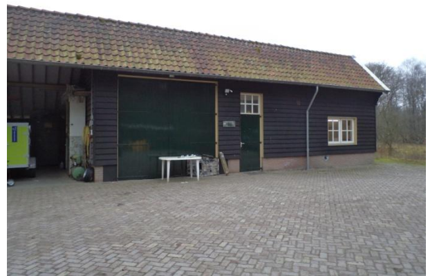
Westelijk deel werkschuur: werkplaats, kantine- en kantoorruimte
