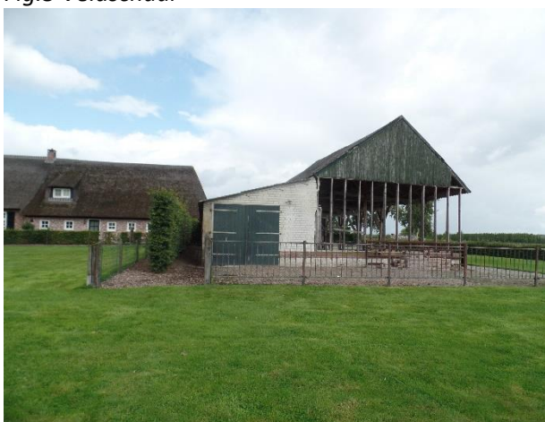
Fig.5. Zicht op zuidelijke kopgevel
