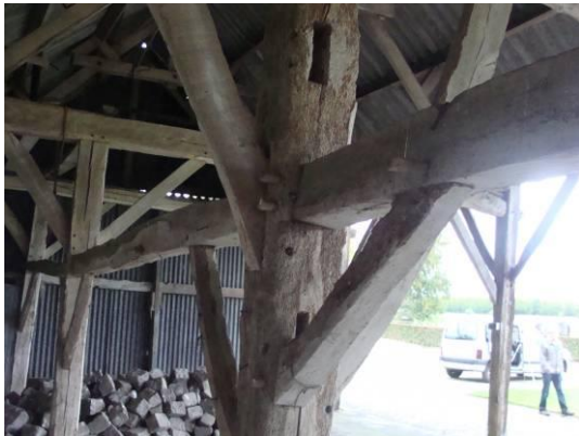
Foto links: staander van het 3 e gebint met loze gaten: sporen van hergebruik.
