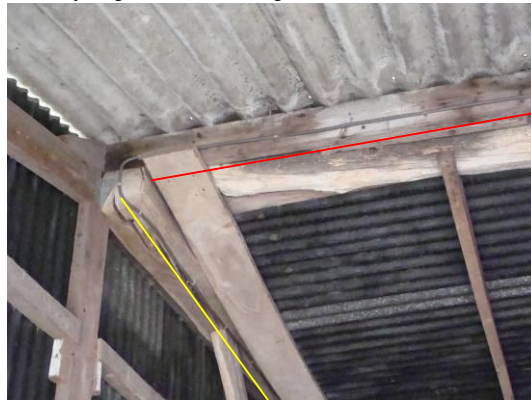
Foto links: de achterste koppelbalk (rood) die rust op de gebintplaat (geel) en diende ter ondersteuning van het voormalige dakschild.
