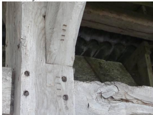
Foto rechts: koppeling in de gebintplaat (boven de deel, ter hoogte van het 3 e gebint).
