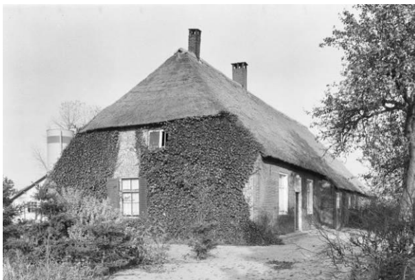
Foto links: kopgevel van de boerderij met het bolkozijn, duidelijk is te zien dat ter plaatse van het voorhuis de lange gevel naar binnen is geplaatst om meer hoogte in deze gevel te creëren.
