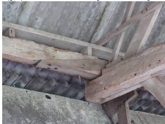
Foto links: dek/ankerbalk van het gebint dat doorsteekt door de stijl, en aan de achterzijde is verankerd met wiggen.
