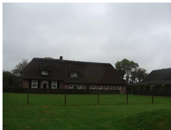
Foto rechts: aanzicht van de huidige boerderij met rechts in beeld de velschuur met het Vlaamse schuur gebint.
