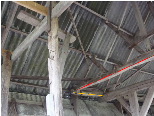
Foto links: de huidige recentere spanten en gordingconstructie van het huidige dak. Foto rechts: vooraan is het recentere en provisorische gemaakte (5e) "gebint" met spant te zien, met in geel de gebintplaat en in rood de achterste koppelbalk.(voorheen het einde van de Vlaamse schuur)
