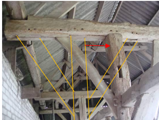
Foto rechts: duidelijk is te zien aan de loze gaten dat deze staander ooit bij hergebruik in de huidige schuur verder naar binnen is geplaatst.
