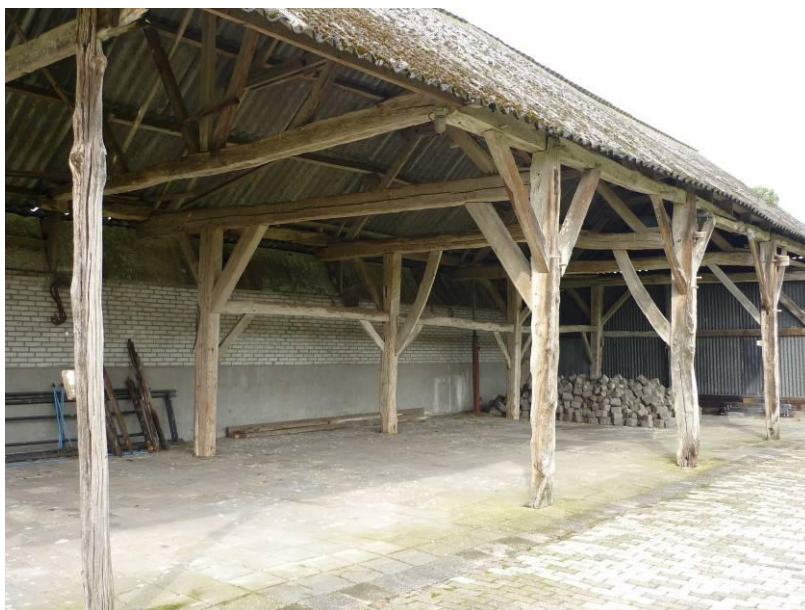
Schuur met Vlaamse schuurgebint, nu in gebruik als veldschuur en stal.
