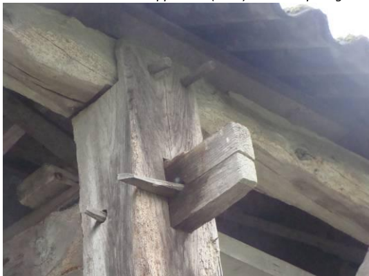
Foto links: dek/ankerbalk van het gebint dat doorsteekt door de stijl, en aan de achterzijde is verankerd met wiggen.
