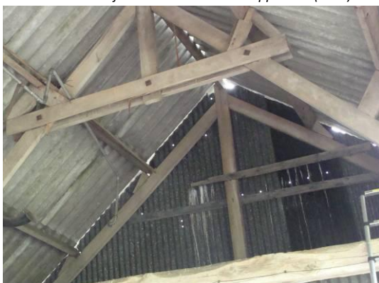
Foto links: de huidige recentere spanten en gordingconstructie van het huidige dak. Foto rechts: vooraan is het recentere en provisorische gemaakte (5e) "gebint" met spant te zien, met in geel de gebintplaat en in rood de achterste koppelbalk.(voorheen het einde van de Vlaamse schuur)
