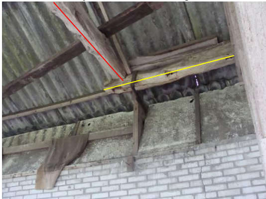
Foto links: de achterste koppelbalk (rood) die rust op de gebintplaat (geel) en diende ter ondersteuning van het voormalige dakschild.
