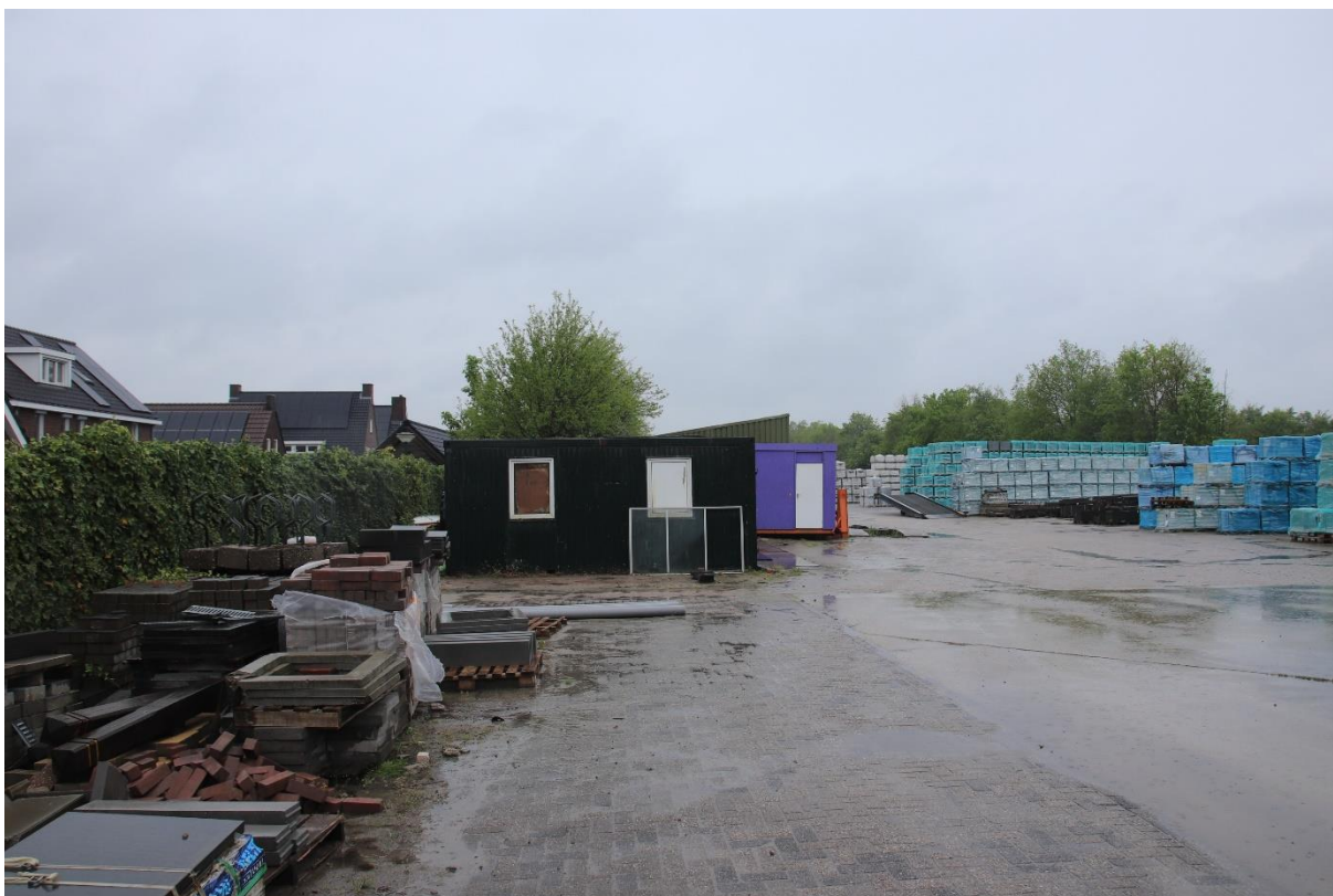
Foto 2: Beeld van het opslagterrein en enkele van de te verwijderen (open) opslagruimtes
