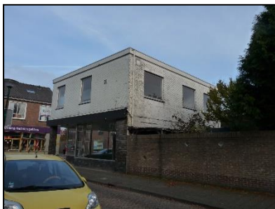
Figuur 3. Pand op de hoek van de Hoofdstraat 18.
