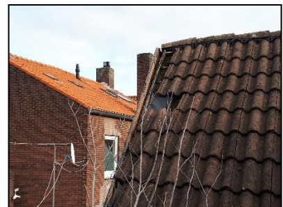
Figuur 14. Ruimten onder dakpannen.
