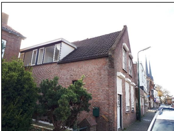
Figuur 10. Dakgoot die toegang verleent tot ruimten tussen het dak en het dakbeschoot.
