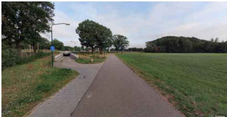
13. Zicht op tunnel richting de Efteling
