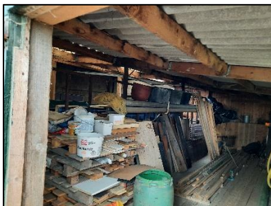
Figuur 7. Binnenzijde van het te slopen schuurdeel.
