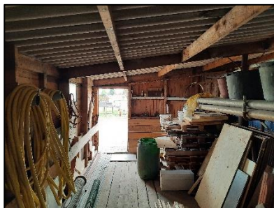
Figuur 8. Binnenzijde van het te slopen schuurdeel.
