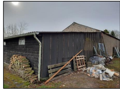
Figuur 6. Westzijde van het te slopen schuurdeel.
