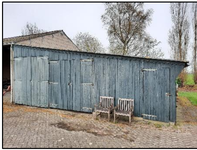
Figuur 4. Oostzijde van het te slopen schuurdeel.
