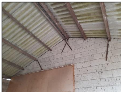
Figuur 11. Binnenzijde van het middenstuk schuur.
