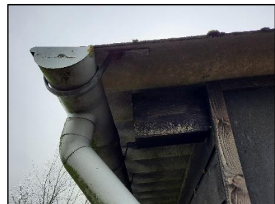
Figuur 9. Aansluitende dakgoot en gevels op het golfplaten platte dak.
