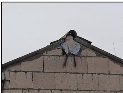
Figuur 10. Noordzijde van het middenstuk schuur met zicht op ruimte tussen nokpannen.
