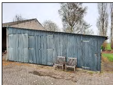
Figuur 4. Oostzijde van het te slopen schuurdeel.
