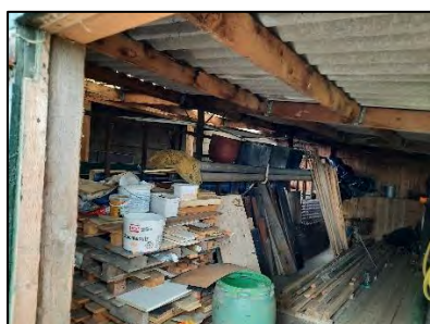
Figuur 7. Binnenzijde van het te slopen schuurdeel.
