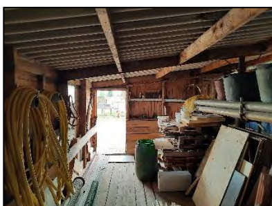
Figuur 8. Binnenzijde van het te slopen schuurdeel.
