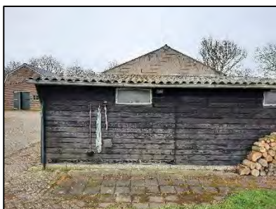
Figuur 5. Noorzijde van het te slopen schuurdeel.
