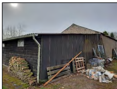
Figuur 6. Westzijde van het te slopen schuurdeel.
