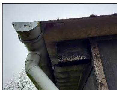
Figuur 9. Aansluitende dakgoot en gevels op het golfplaten platte dak.
