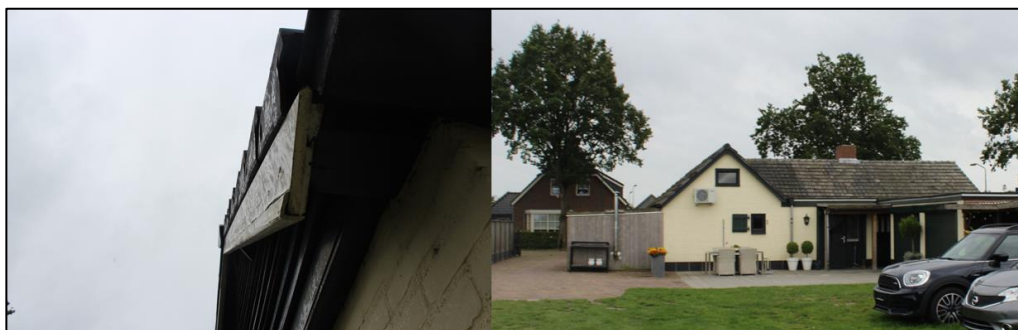
Figuur 6 Het dak van de bebouwing aan de Erasstraat 107 is ontoegankelijk voor huismussen.
