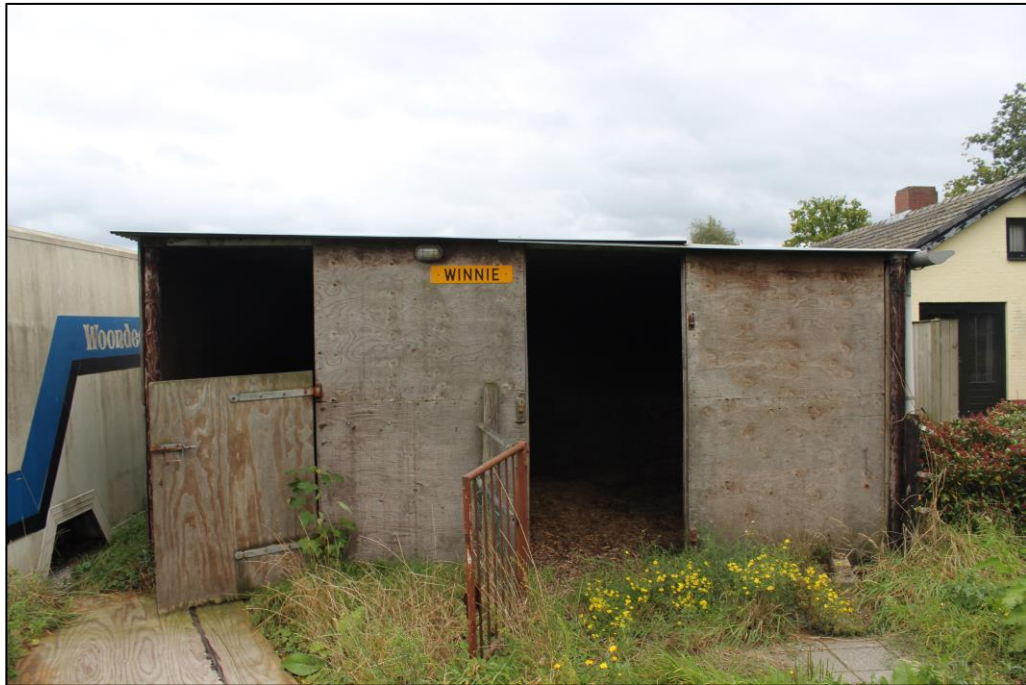
Figuur 3 Eén van de schuren op de planlocatie welke gesloopt zal worden.
