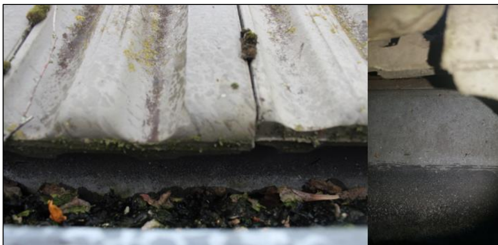
Figuur 5 Het dak van de bebouwing aan de Erasstraat 107 is ontoegankelijk voor huismussen.
