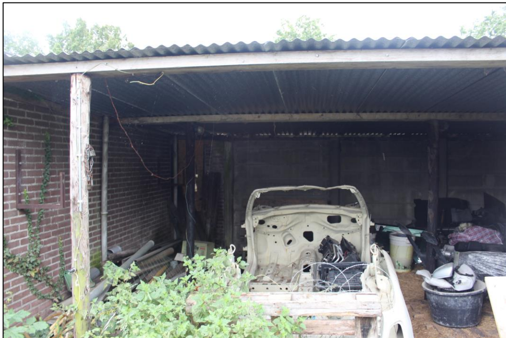
Figuur 4 Eén van de schuren op d planlocatie welke gesloopt zal worden.
