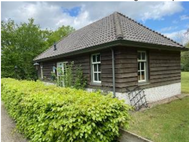
Figuur 1: receptie (65m 2 ) bij entree accommodatie
