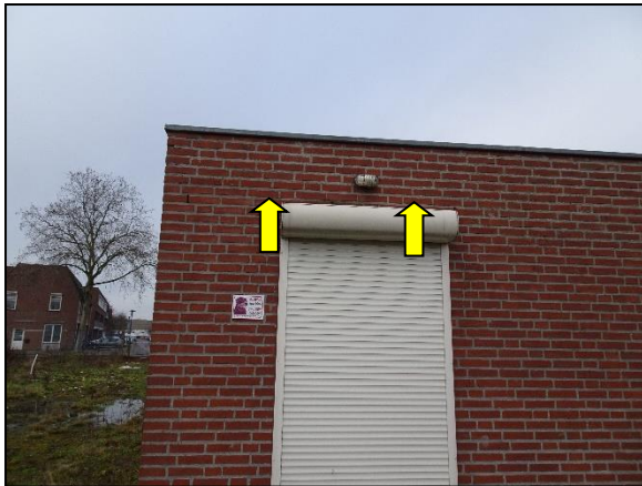
Figuur 10. Toegang voor vleermuizen in de vorm van open stootvoegen aan de achterzijde van Marktstraat 33-37.
