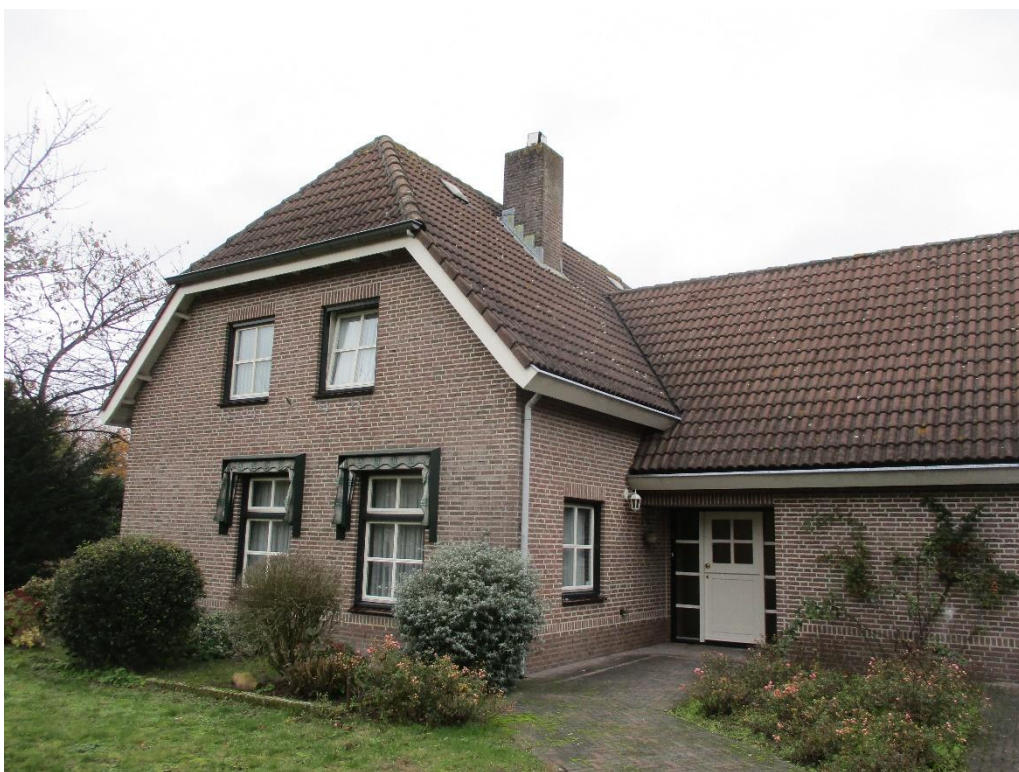
Figuur 2 De woning is opgetrokken uit gemetselde muren met geïsoleerde spouw en wolf- en steekdak met dakpannen.
