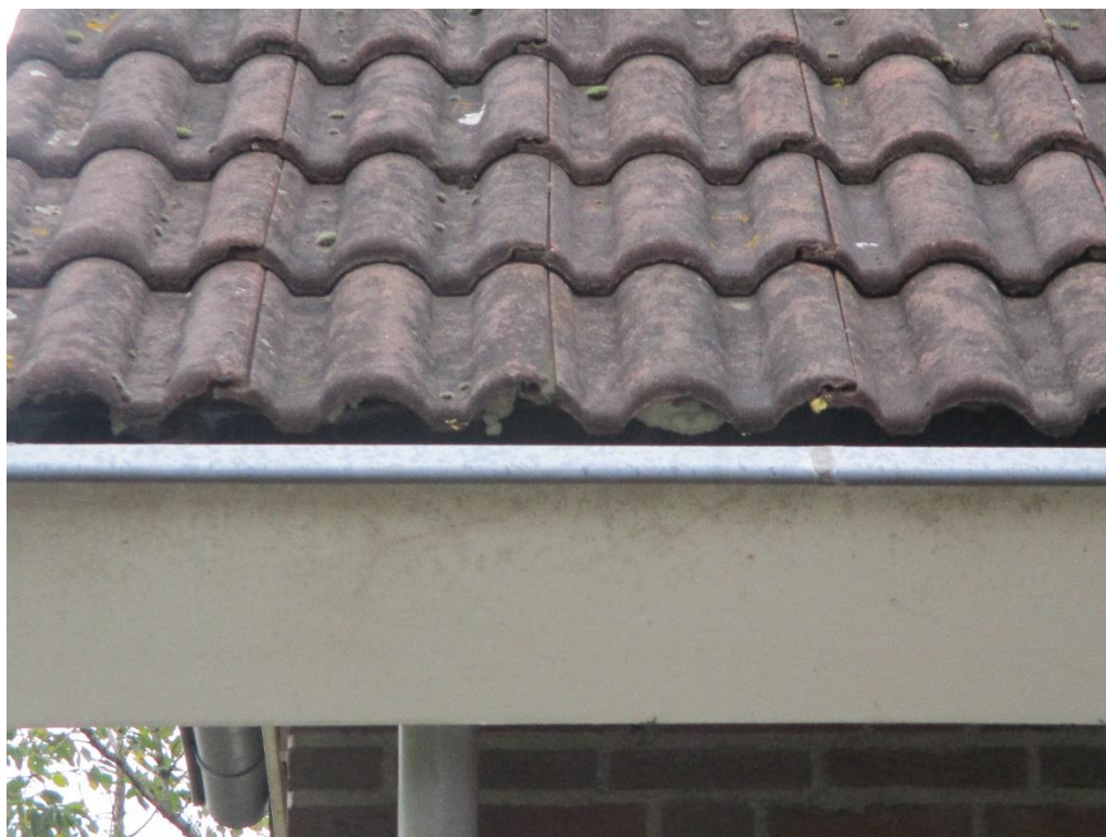
Figuur 5 De ruimte onder de dakpannen is afgedicht met purschuim.
