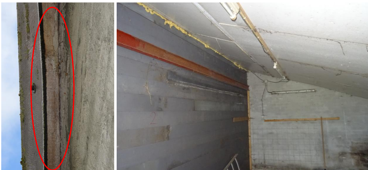
Afbeelding 7 en 8. Overstek afgesloten d.m.v. houten latten. Verder bevat de stal geen spleten en scheuren groter dan 15 mm. Ook zijn veel naden en kieren afgedicht met purschuim. Bron: R.J.L. Bijvelds 17-05-2021
