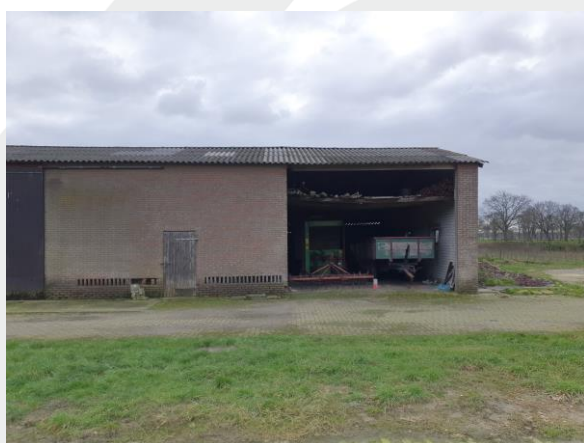
Open loods met materialen.
