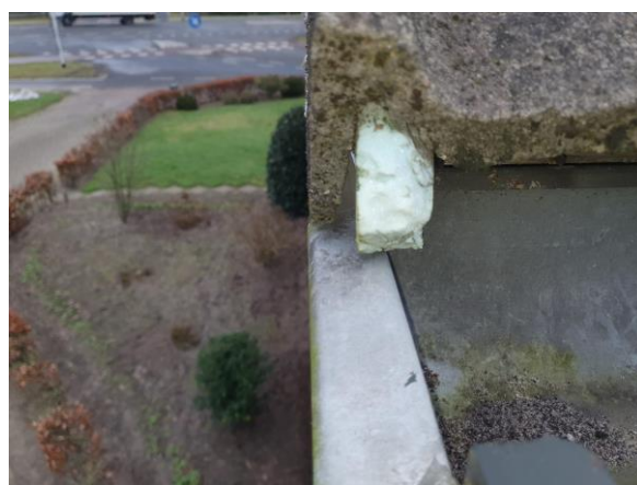
Dupanel achter gevelpannen.
