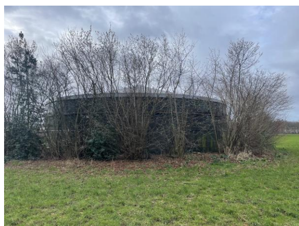
Mestsilo met groenstructuren.
