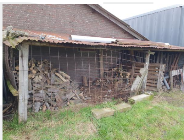
Houtopslag achter tegen de open loods. Gecontroleerd op de aanwezigheid van marterachtigen: geen sporen aangetroffen.
