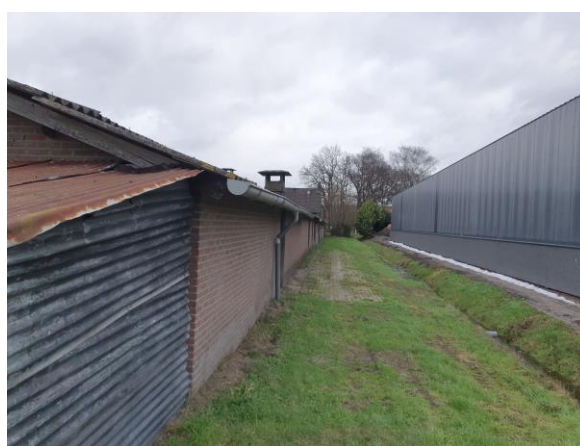
Voormalige varkensstal ter hoogte van de perceelsgrens. Ondiepe sloot valt in de zomerperiode droog.
