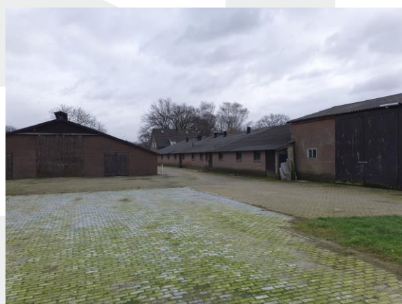
Stallen. Groot gedeelte van het terrein is verhard met klinkers.
