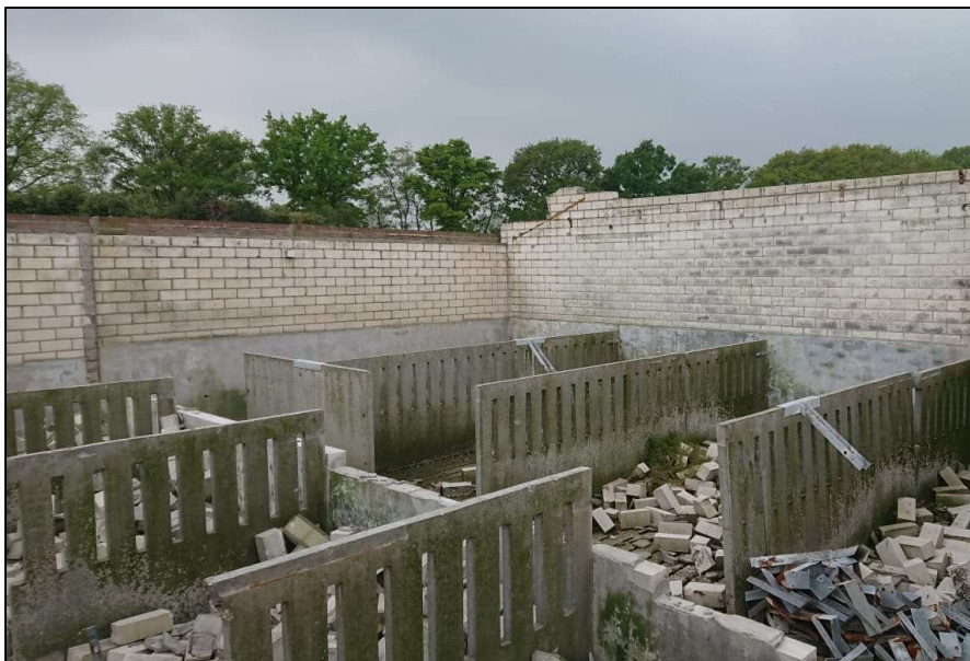
Varkenshokken te slopen bebouwing
