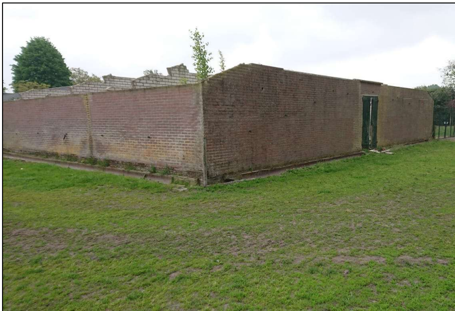
Gevelaanzicht te slopen bebouwing
