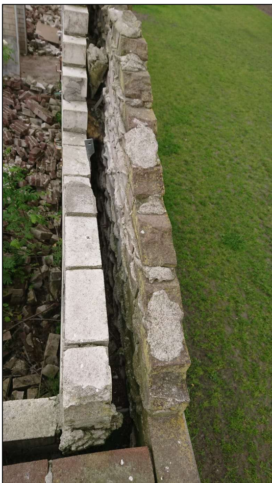
Overzicht open spouwen van de te slopen bebouwing
