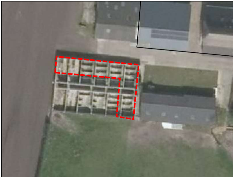
Overzicht te slopen bebouwing
