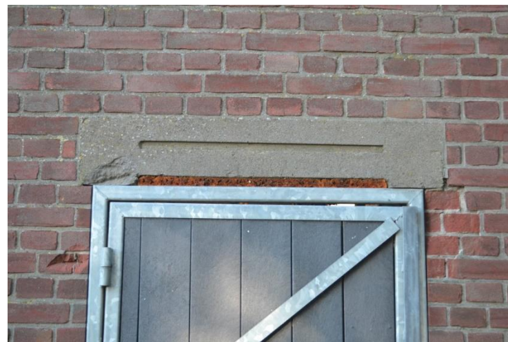
Breder ingezaagde deur onder betonlatei.
