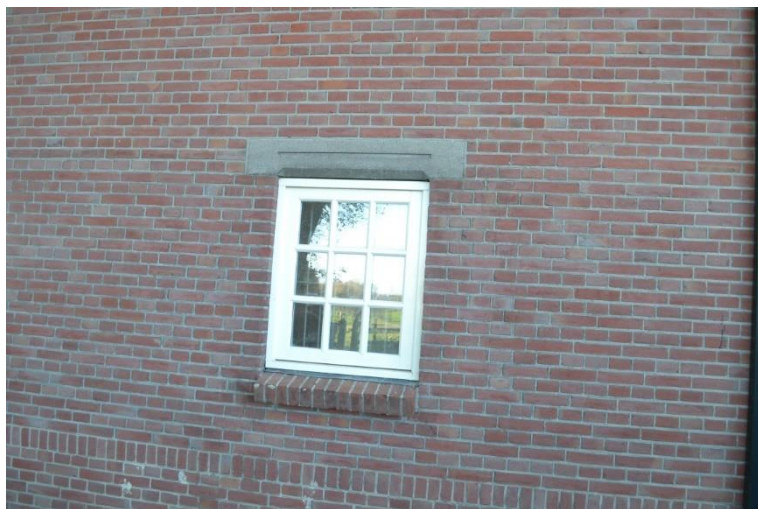
Houten venster onder geprofileerde betonlatei.
