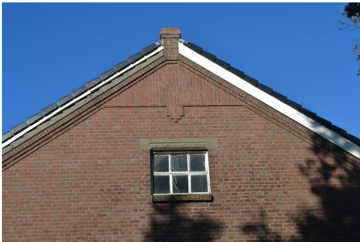
Metselaccent in topgevel.
