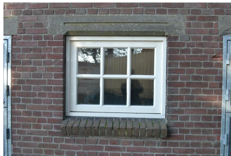
Betonvenster onder geprofileerde betonlatei.
