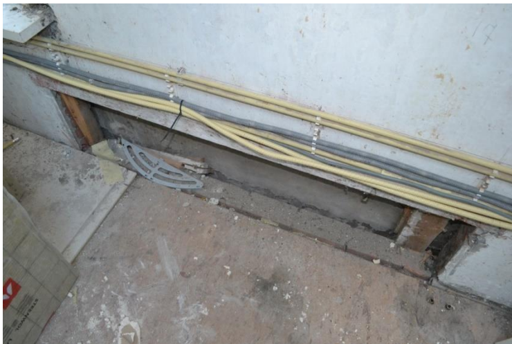
Oorspronkelijke ingebouwde rolluikbakken.
