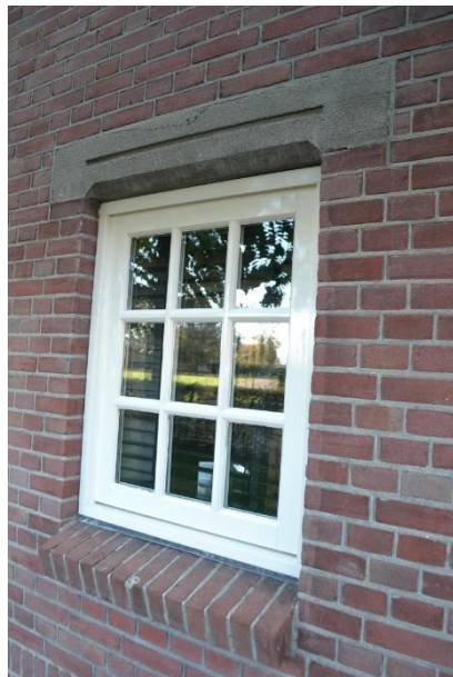
Houten venster onder betonlatei.
