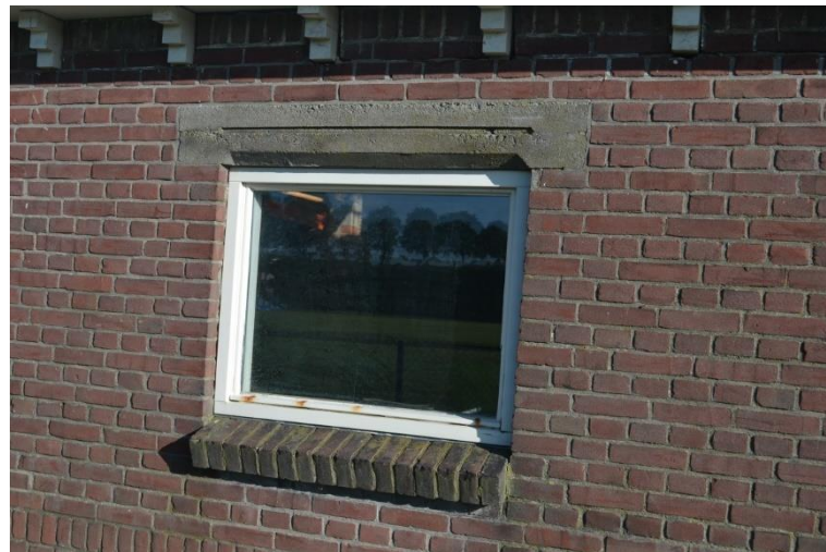
Vernieuwd kozijn in gevelopening onder betonlatei.
