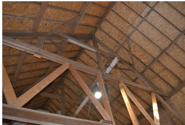
Oorspronkelijke spantconstructie met recentere verstevigingen.
