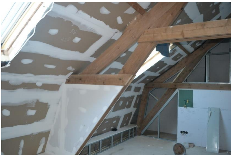
Vernieuwde afwerkingen dakvlak.
