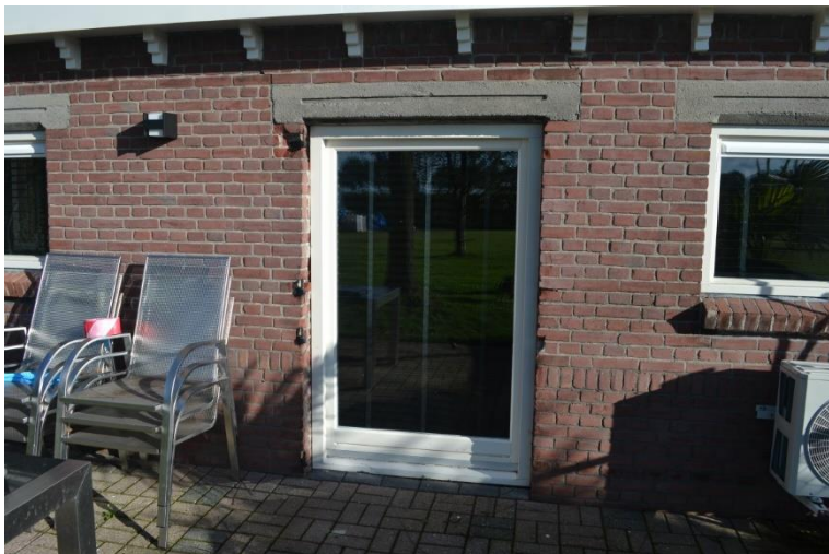
Vernieuwd kozijn in deuropening.
