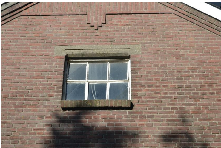
Oorspronkelijk kozijn op verdieping.
