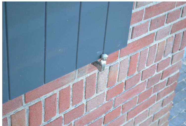
Oorspronkelijk luikwervel.
