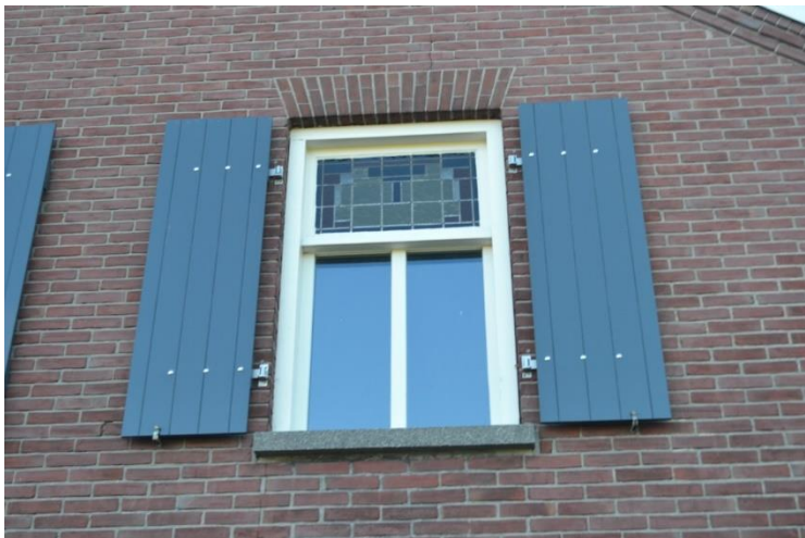
Oorspronkelijk venster onder strek met glas-in-lood met vernieuwde luiken.
