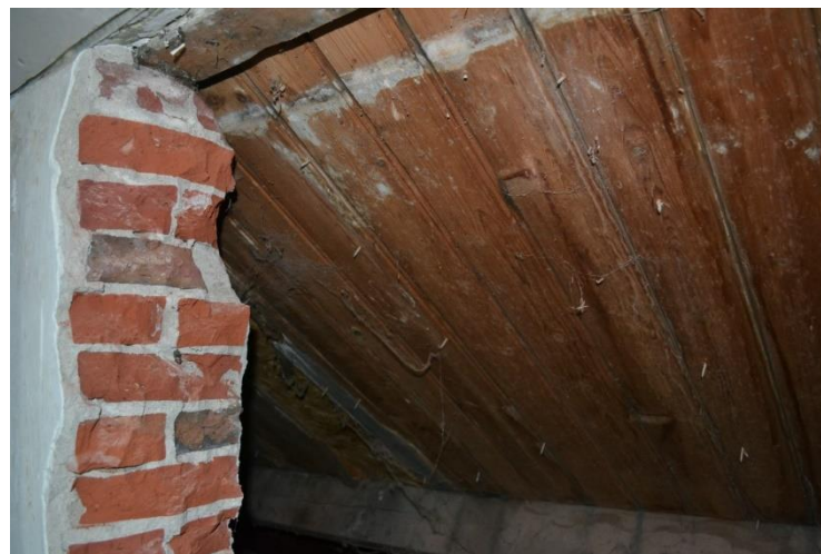
Oorspronkelijk dakbeschoot.
