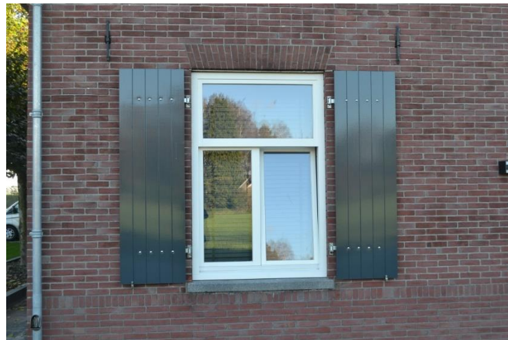
Vernieuwd houten kozijn met houten luiken.
