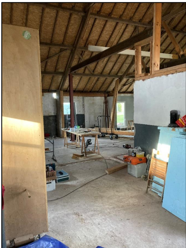
Binnenzijde stalgedeelte langgevelboerderij
