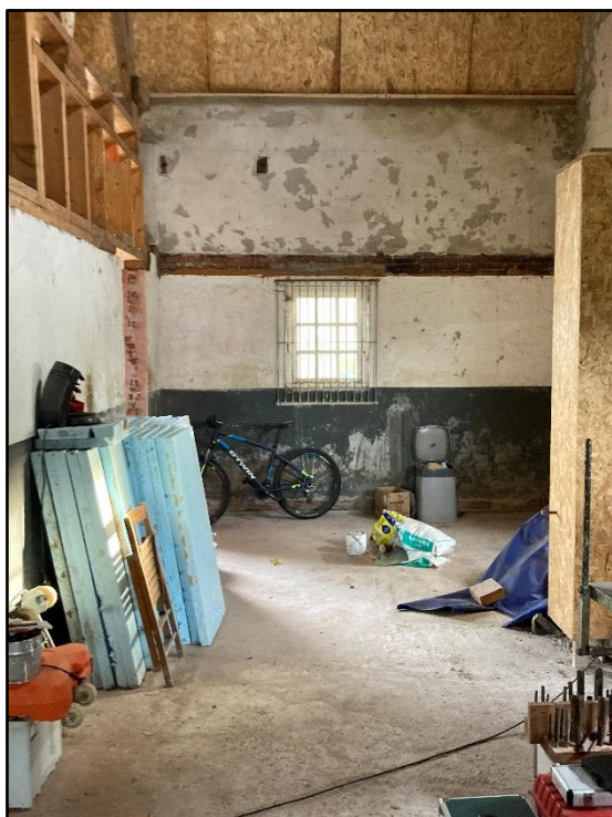
Binnenzijde stalgedeelte langgevelboerderij
