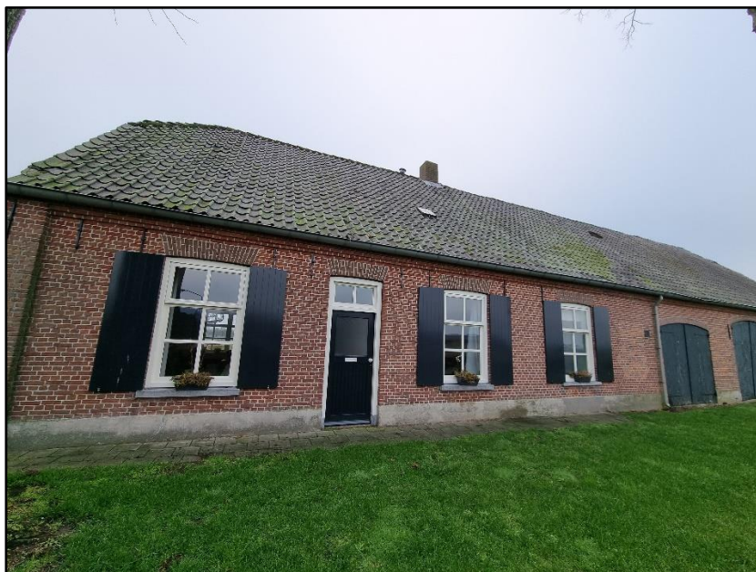
Afbeelding 4: Zichtfoto cultuurhistorische bedrijfswoning aan de Gasthuisweg 8 te Hilvarenbeek
