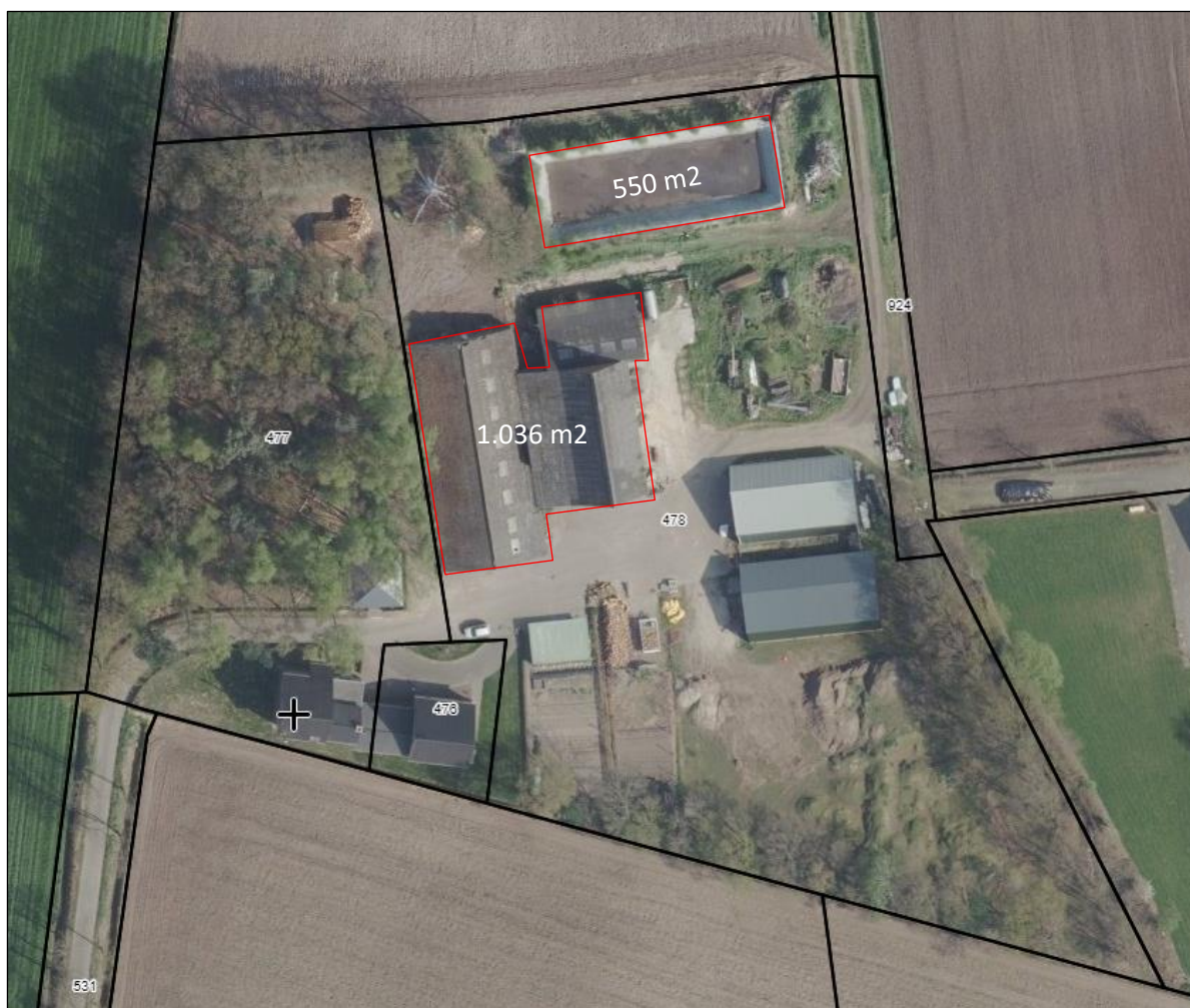
Afbeelding 7 Weergave gesloopte bebouwing in de bestaande situatie
