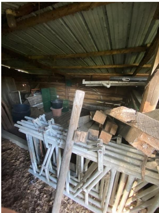
Binnenkant stierenstal (roostervloer en damwand dak)
