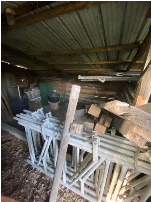
Binnenkant stierenstal (roostervloer en damwand dak)
