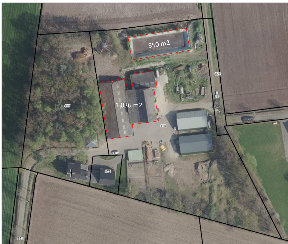
Afbeelding 7 Weergave gesloopte bebouwing in de bestaande situatie
