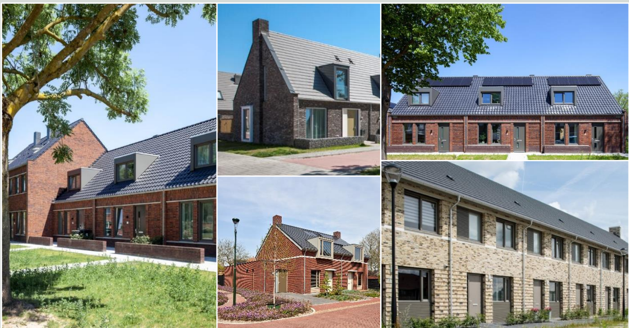
Accenten in gevel en dakvlak door kozijnen en dakkapellen
