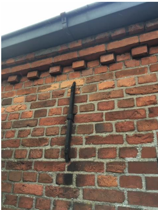
Muurankers met onder de dakrand een zinken dakgoot en muizentand.
