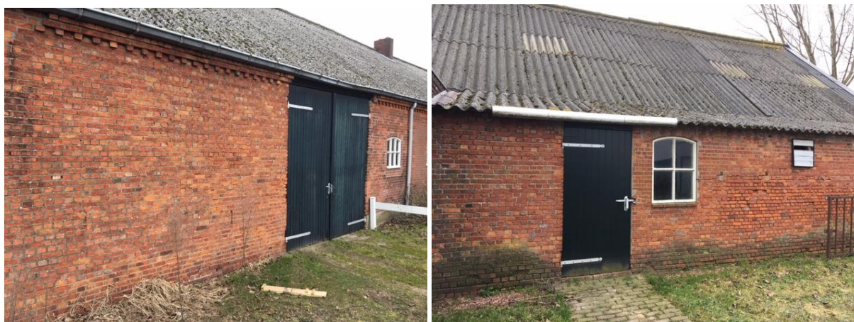
De voorgevel en achtergevel uitgevoerd met handvormstenen in kruisverband met onder de dakrand een zinken dakgoot en muizentand.
