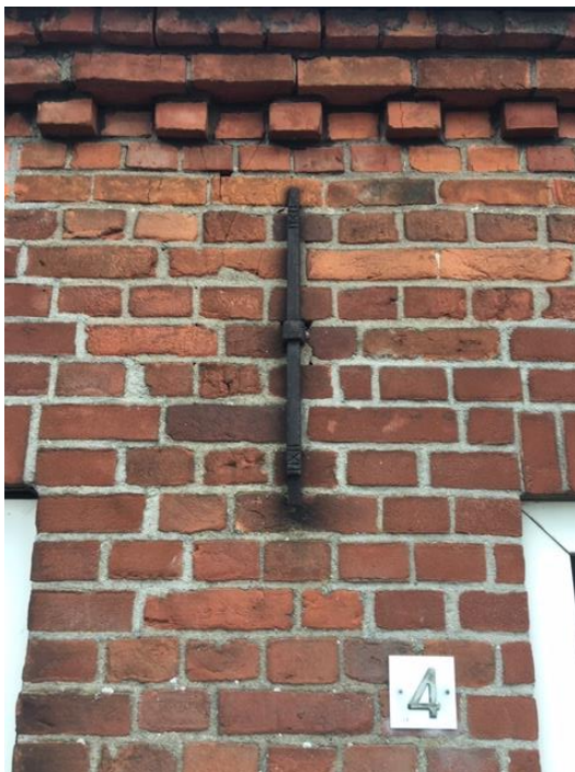
Muurankers met onder de dakrand een zinken dakgoot en muizentand.
