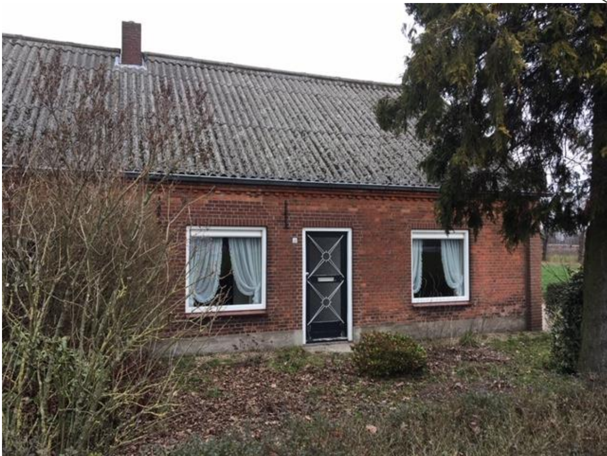
Het herkenbare woongedeelte met daarbij de voorgevel uitgevoerd met handvormstenen in kruisverband met onder de dakrand een zinken dakgoot en muizentand.
