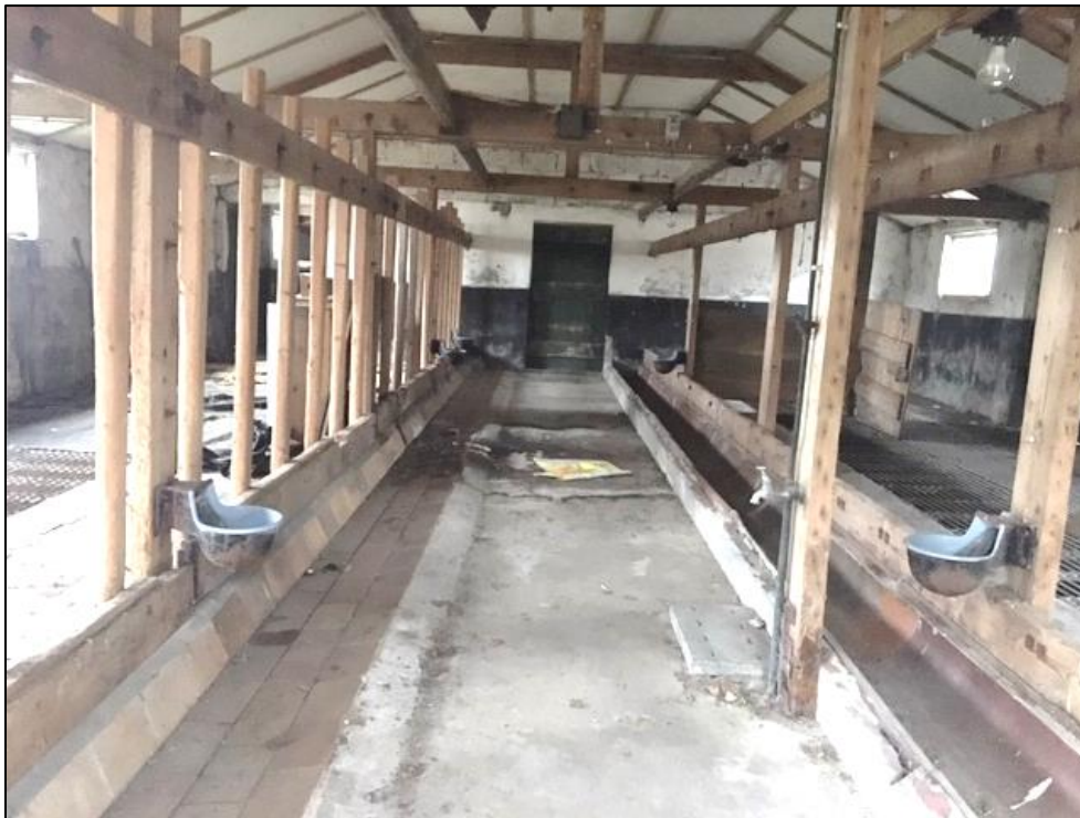
Stal 1 uitgevoerd met steensmuur zonder spouw (te slopen)
