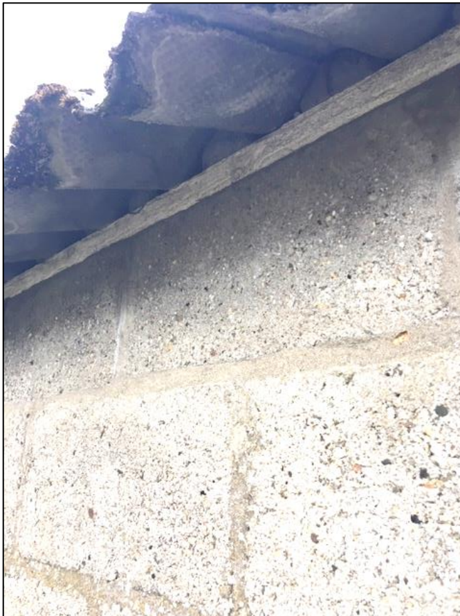
Stal 1 afwerking openingen golfbeplating met cement
