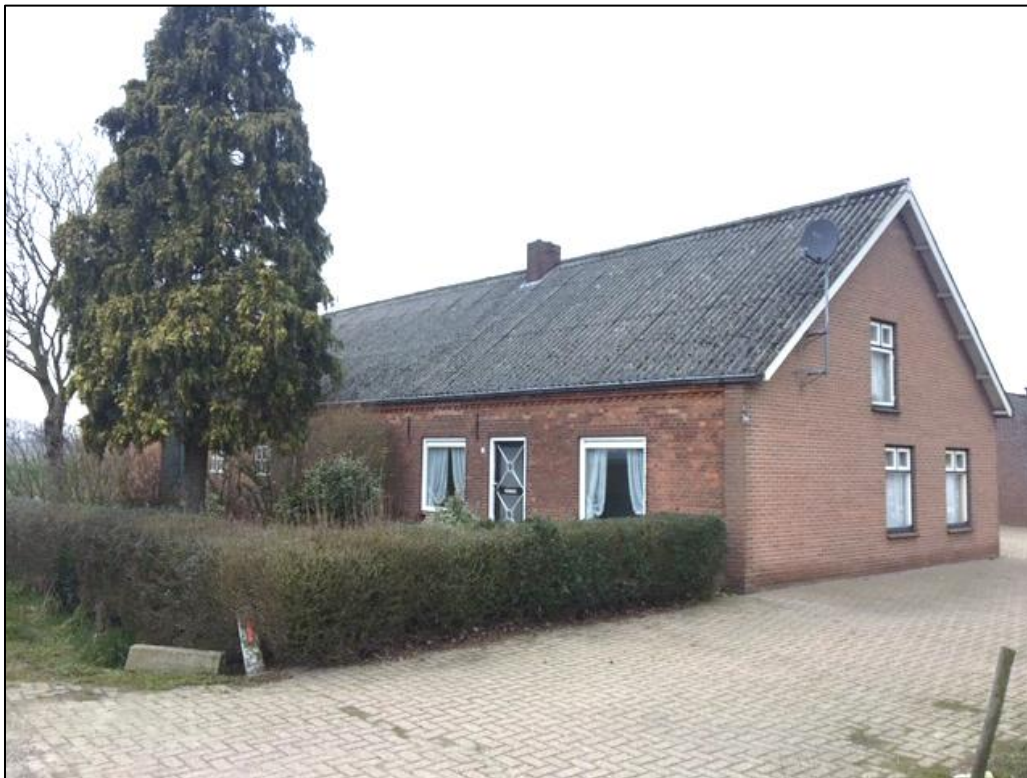
Voorgevel woongedeelte (blijft gehandhaafd)
