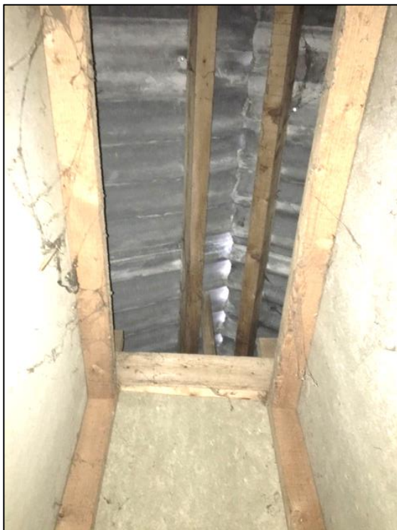
Stal 1 ruimte boven verlaagd plafond (grote klimatologische invloed, geen verblijfplaatsen, baltspiegels of overige sporen aangetroffen)
