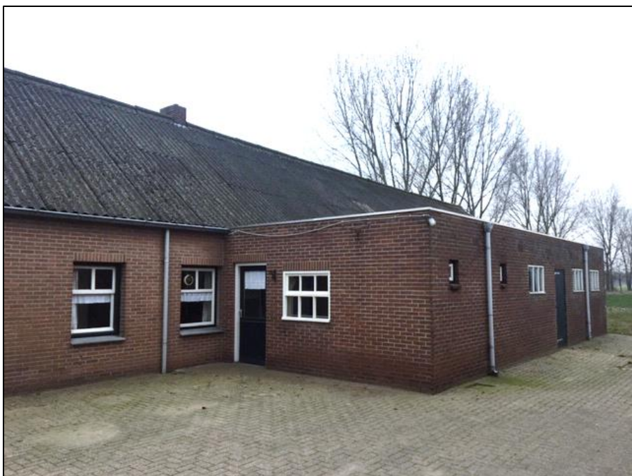
Achtergevel woongedeelte (blijft gehandhaafd)
