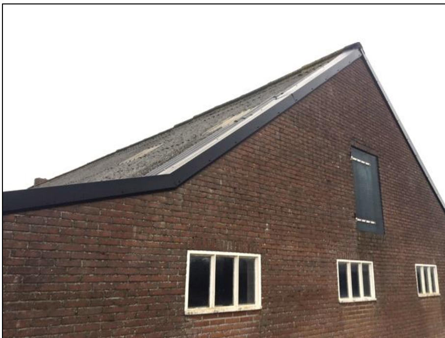
Strakke dakrandafwerking zijgevel stalgedeelte
