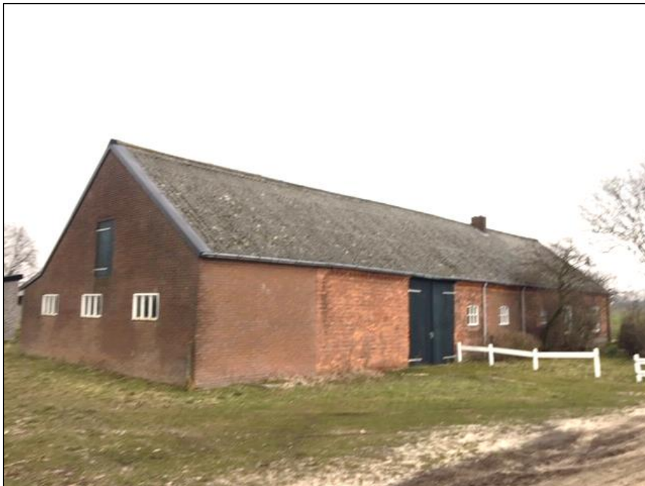
Voorgevel stalgedeelte (steensmuur zonder spouw)
