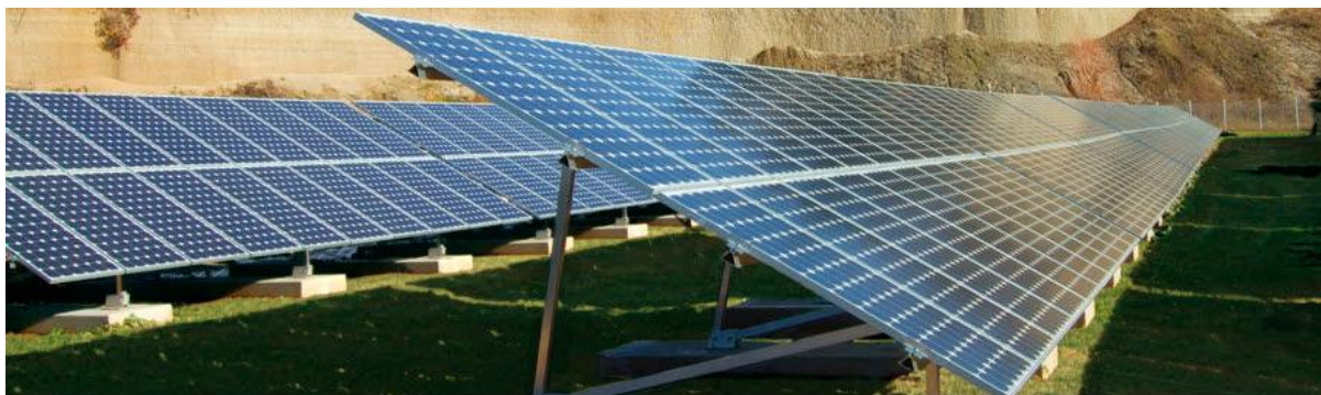
Afbeelding 17: Voorbeeld onderconstructie met betonvoeten
