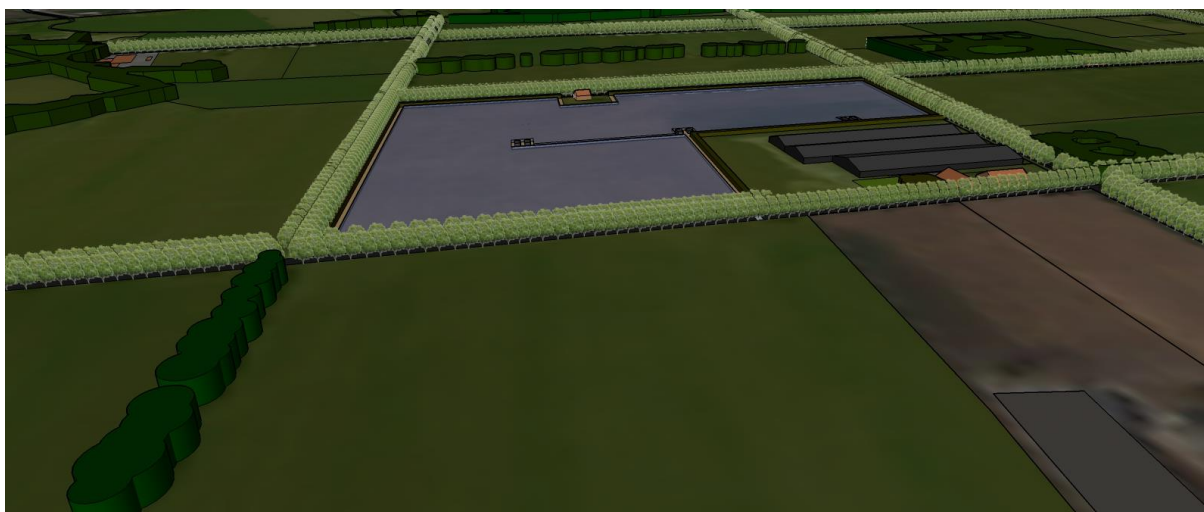
Zicht vanuit het oosten op het zonnepark met op de voorgrond de Van de Veldenweg.
