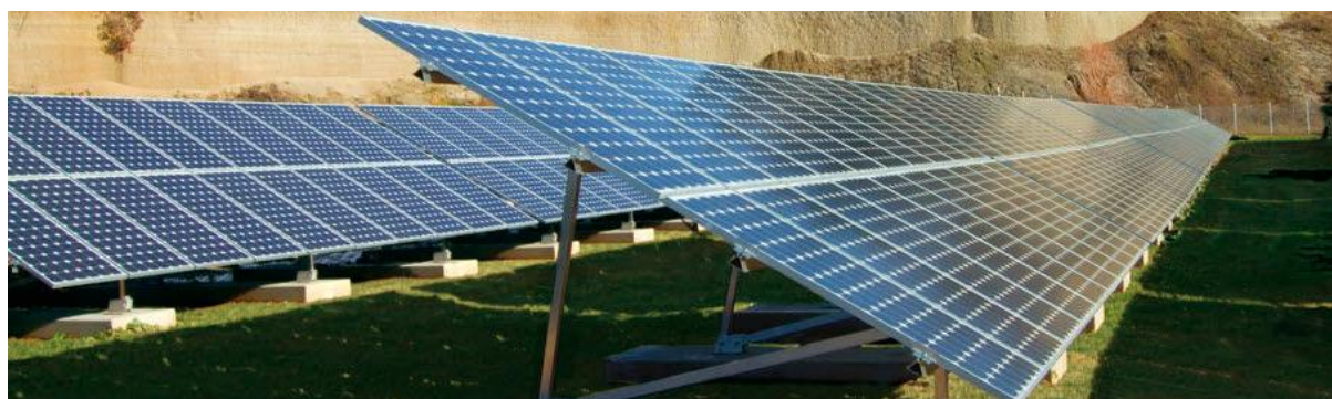
Afbeelding 16: Voorbeeld onderconstructie met betonvoeten
