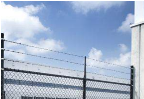
referentie: hekwerk met fauna passage (30cm vrije ruimte) materiaal: staal kleur: grijs / thermisch verzinkt
