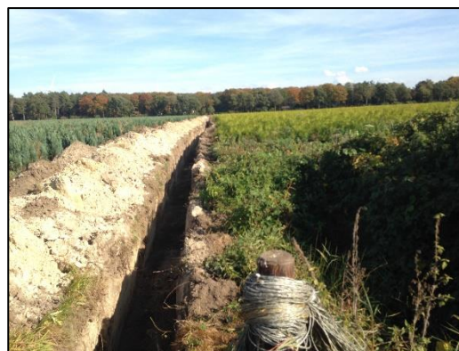
Foto 10. Noordelijke grens plangebied oostelijk perceel
