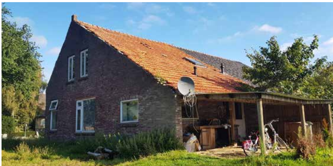
Het voorhuis, foto genomen vanaf de zuidzijde.
