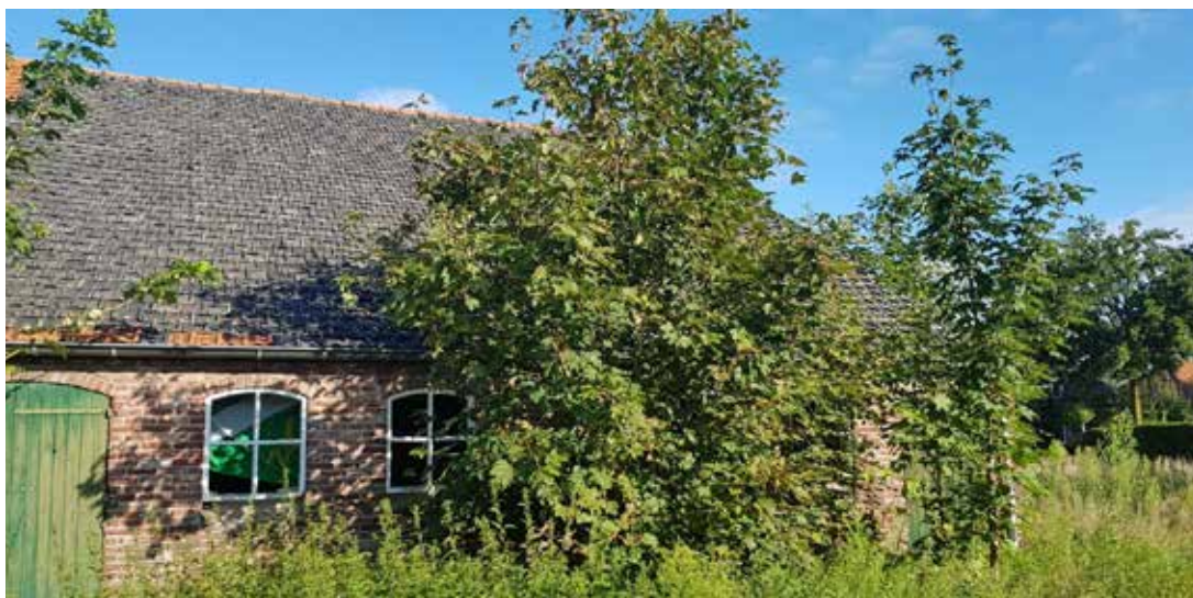
Het achterhuis, foto genomen aan de zuidzijde
