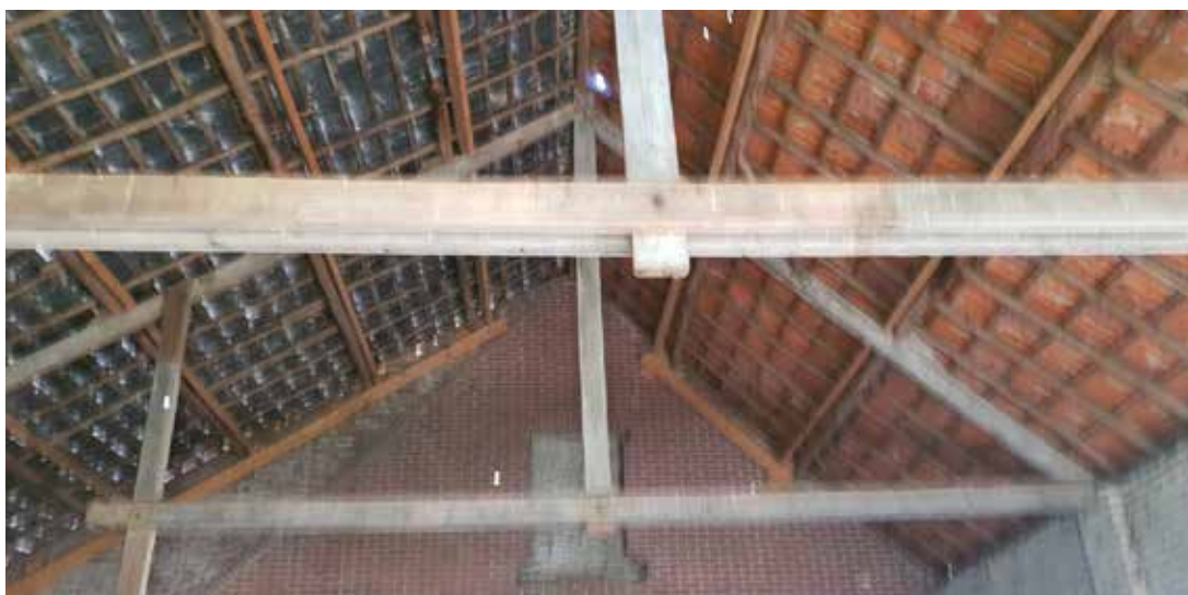
Binnenzijde van het achterhuis (schuur), open van opzet, geen dakbeschoot aanwezig.
