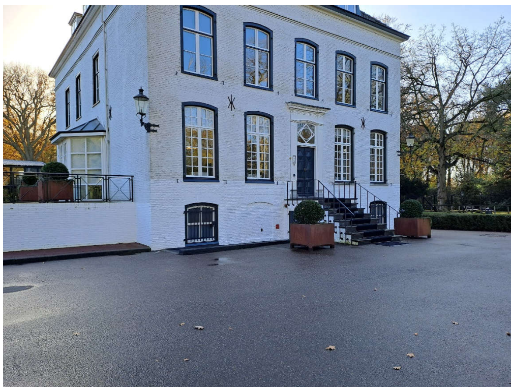
Foto 2: overzicht, oorspronkelijk landhuis, Groenendaal 1
