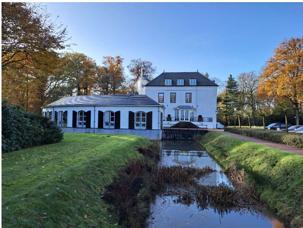
Foto 3: overzicht, landhuis met aan de achterzijde de in 1995 gerealiseerde uitbouw
