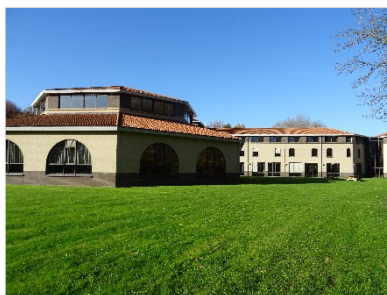
Figuur 2.3. Zuidzijde van de bebouwing.
