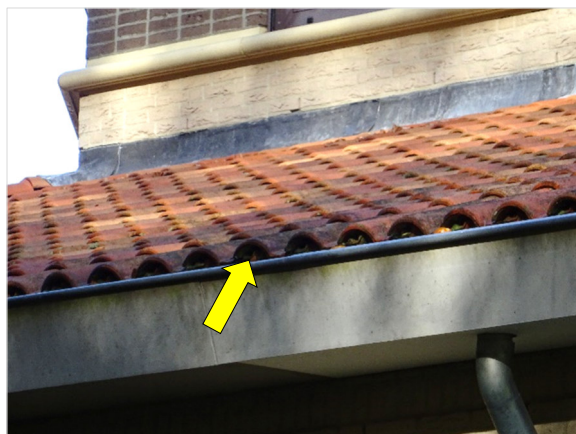
Figuur 5.2 Openingen onder de dakpannen.
