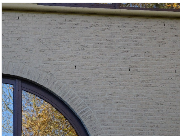
Figuur 5.4 Open stootvoegen.
