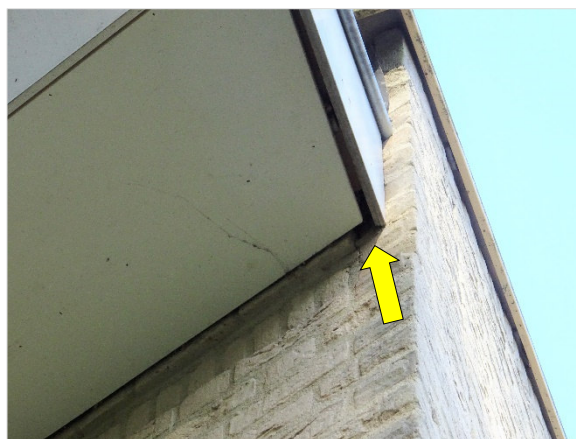
Figuur 5.5 Opening tussen de boeidelen.
