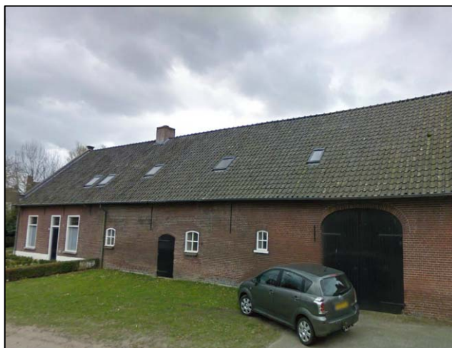
Aanzicht van de voorgevel van de te splitsen boerderij
