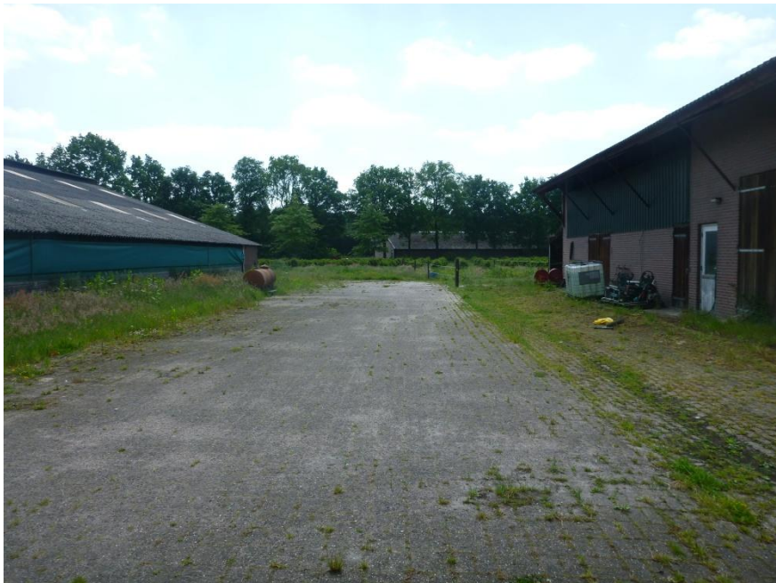
Fig. 3.11: Leegstaande boerderijlocatie in het zuidoostelijke deel van het plangebied.
