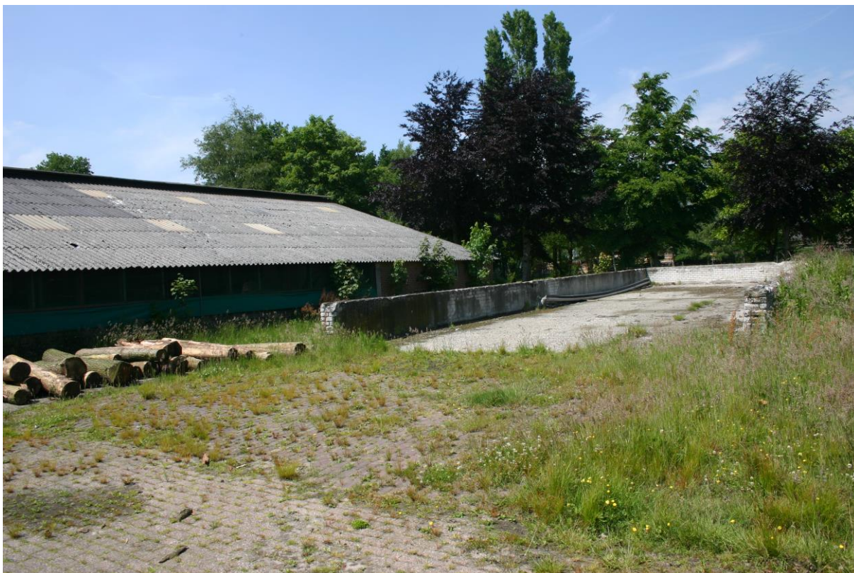
Figuur 2. Het grotendeels gesloopte gebouw en één van de te slopen schuren
