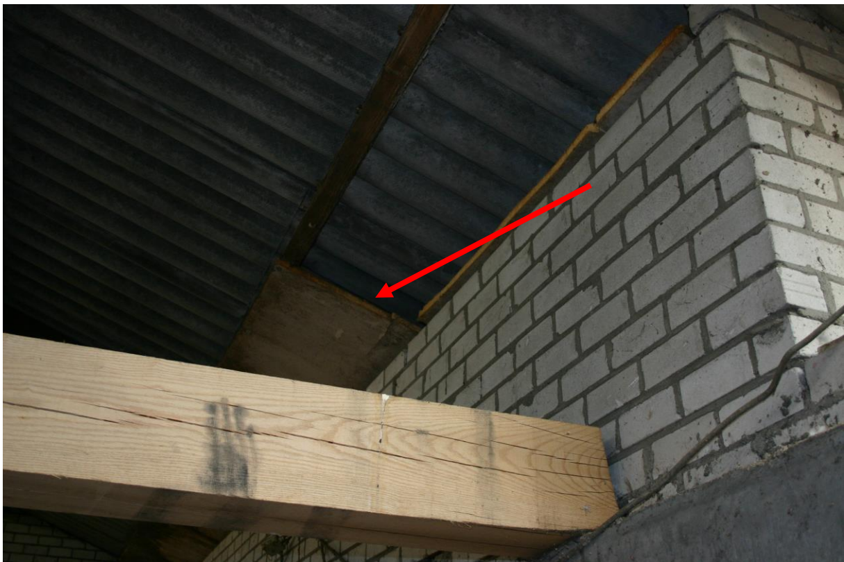
Figuur 8. De plafondplaten waarop de twee kerkuilen werden aangetroffen (de rode pijl geeft de invliegopening weer).
