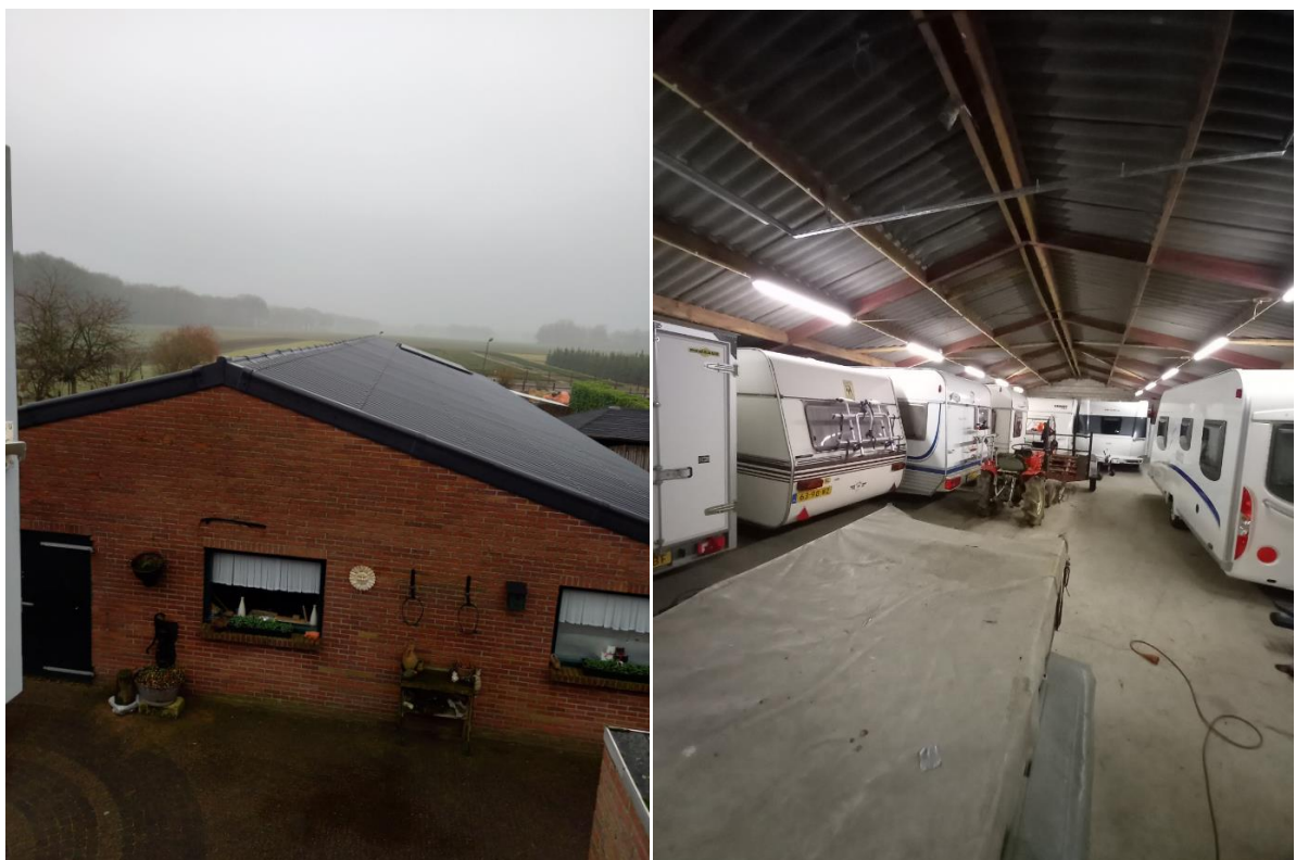
Figuur 6: Loods met statische opslag
