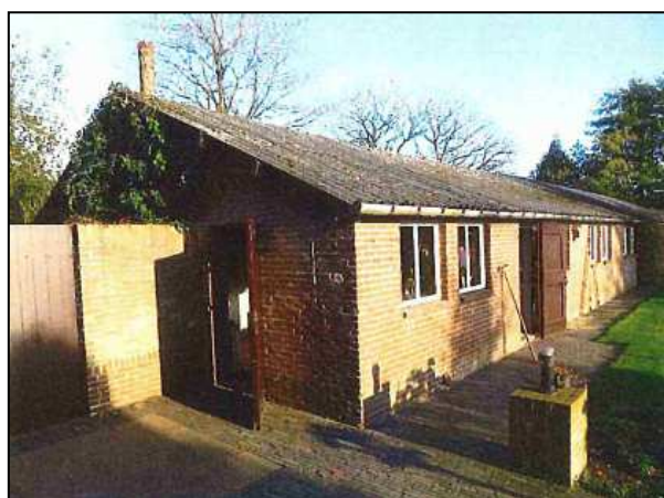
Figuur 5: Beeld van het bijgebouw in de huidige situatie
