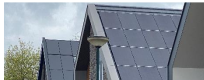
Daken van antraciet, zonnepanelen geïntegreerd in het dakvlak
