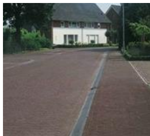
Klinkerbestrating op rijweg en trottoir
