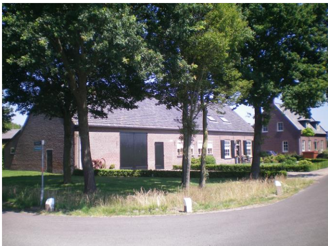
voorzijde bestaande langgevelboerderij Driehuizerweg 17
