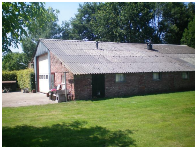
Bestaande schuur achter Driehuizerweg 17
