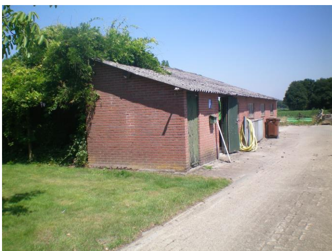
Aanzicht bijgebouw achter woning Driehuizerweg 19
