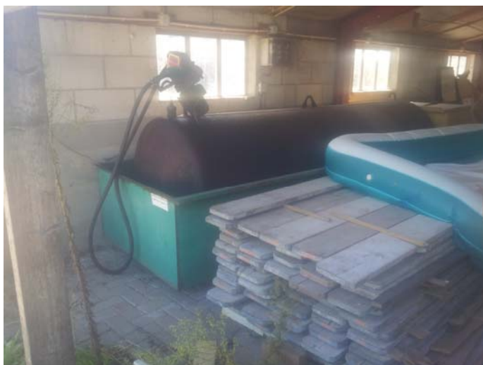
Afbeelding 3: bovengrondse brandstoftank met afnamepomp
