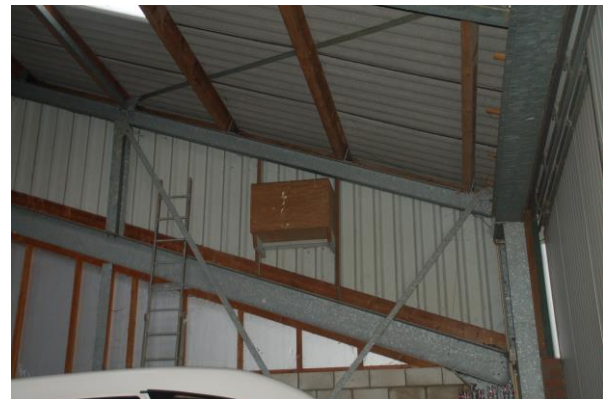
Binnenzijde loods met uilenkast.
