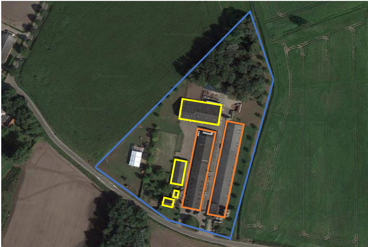
Met globaal omlind de totale planlocatie in blauw, te slopen bedrijfsgebouwen in oranje en bedrijfswoning met bijbouw en loods in geel. Bron: Google Earth
