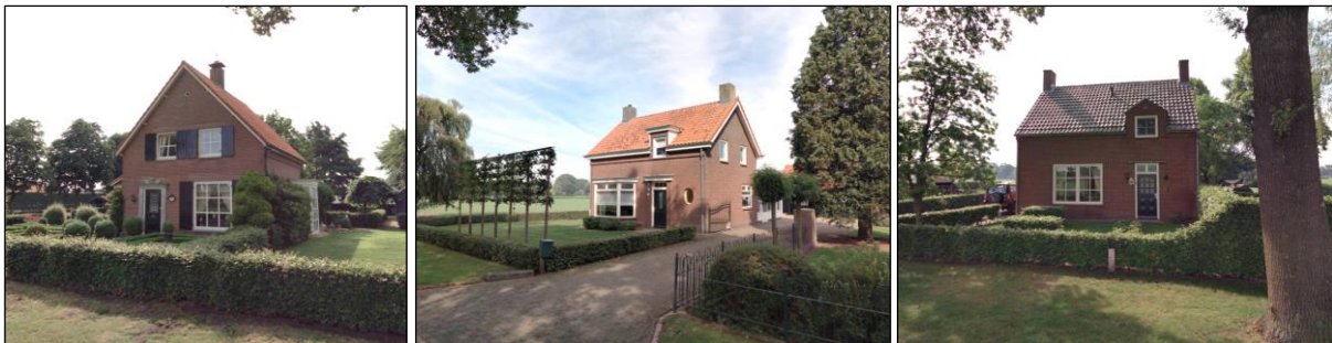
Afbeelding 7: van links naar rechts: sobere bouwvorm van Witvenstraat 19, 18 en 31
