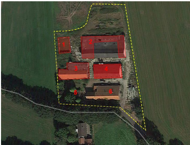
Fig.2. Het onderzoeksgebied is geel omkaderd. De gebouwen, of deel daarvan, die voor sloop in aanmerking komen zijn rood gekleurd. Hieronder een toelichting van de nummering 1. Gierkelder 2-4. Stallen 5. Bijgebouwtje van hoofdgebouw 6. Woonboerderij (hoofdgebouw) (Luchtfoto Google Earth)
