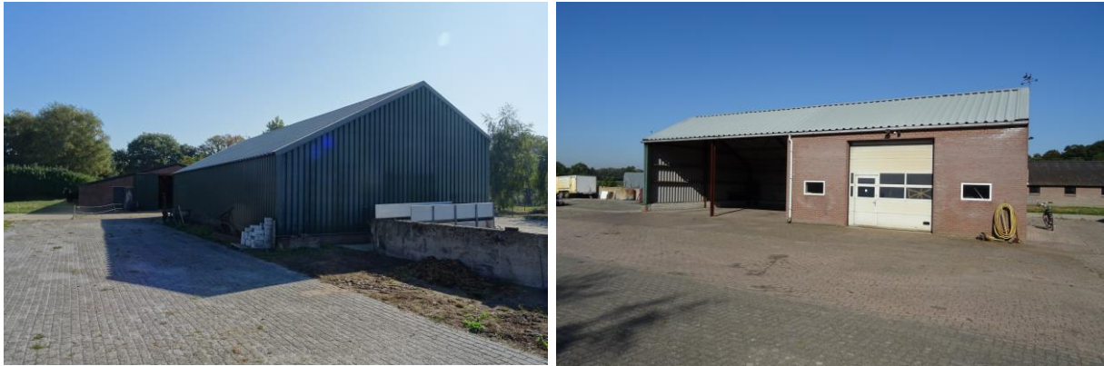
Afbeelding 5 en 6: Bestaande te slopen loods op het kavel. Bron: R.J.L. Bijvelds 21-09-2020
