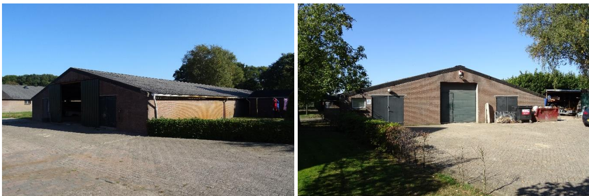
Afbeelding 3 en 4: Bestaande te slopen melkveestal op het kavel. Bron: R.J.L. Bijvelds 21-09-2020
