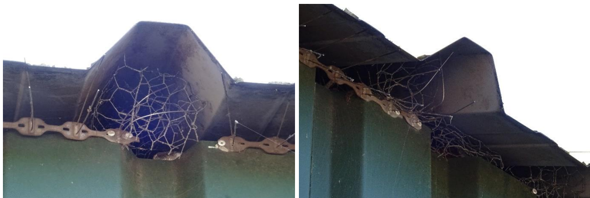
Afbeelding 7 en 8: Daken met vogelwerende middelen om de toegang te versperren. De aanwezigheid van huismussen is uitgesloten door het ontbreken van geschikte verblijfplaatsen. Bron: Rik Bijvelds Datum: 21-09-2020
