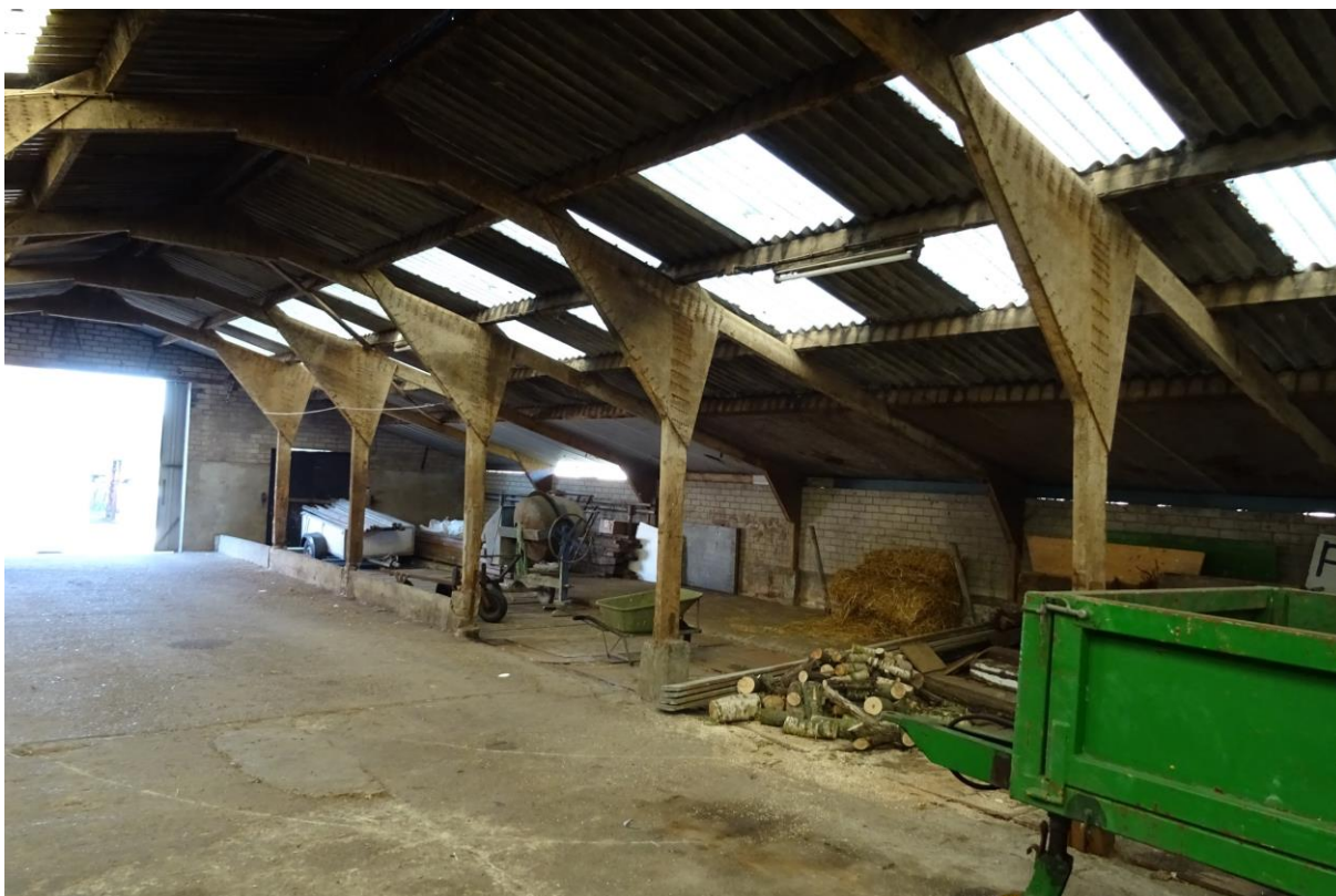
Afbeelding 9: dak van de oude melkveestal bestaat grotendeels uit golfplaten op balken zonder dakbeschoot. Waardoor de meest geschikte verblijfplaatsen voor huismussen ontbreken. Bron: Rik Bijvelds Datum: 21-09-2020
