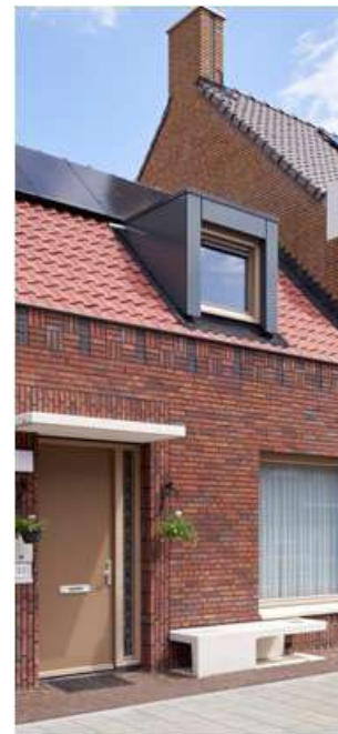
Zorgvuldige detaillering metselwerk en overgang privé-openbaar, toepasbaar in het erf.
