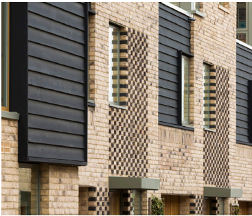
Accent in gevel. Variatie metselwerk
