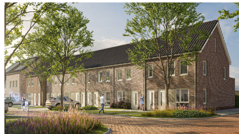
Geleding in de gevel
