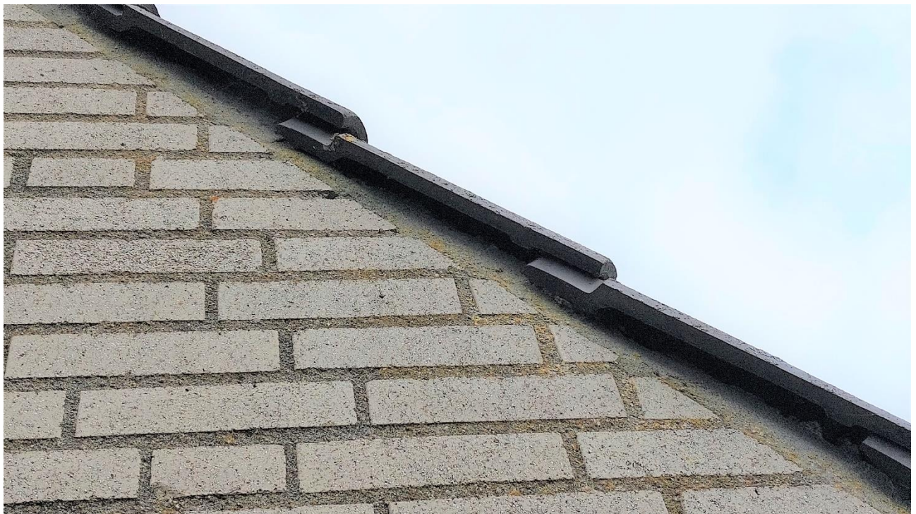
Figuur 4.4.3. Tussen de specie en gevelpannen is ruimte aanwezig waardoor vleermuizen de ruimte onder de dakpannen kunnen bereiken en mogelijk ook de spouw.
