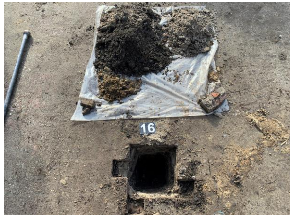
Asbestinspectiegat 16
