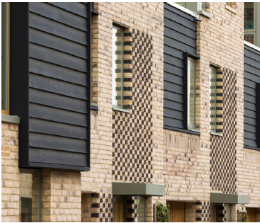
Accent in gevel. Variatie metselwerk
