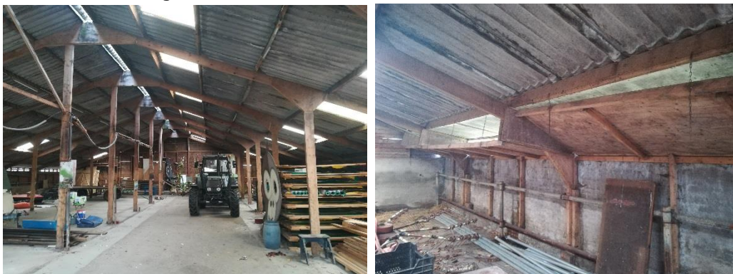
De enkelwandige muren en dakbedekking met ruime openingen naar buiten bieden geen ruimtes voor vleermuizen. (Foto's Laneco)
